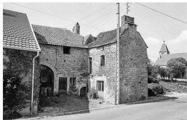
Ferme avec habitation débordante : façade antérieure. Phot. Bernard Lardière IVR43_19817000305Z
