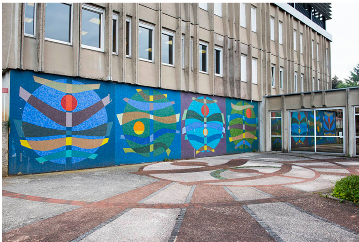
Détail façade, sol et mosaïque de l'externat.
