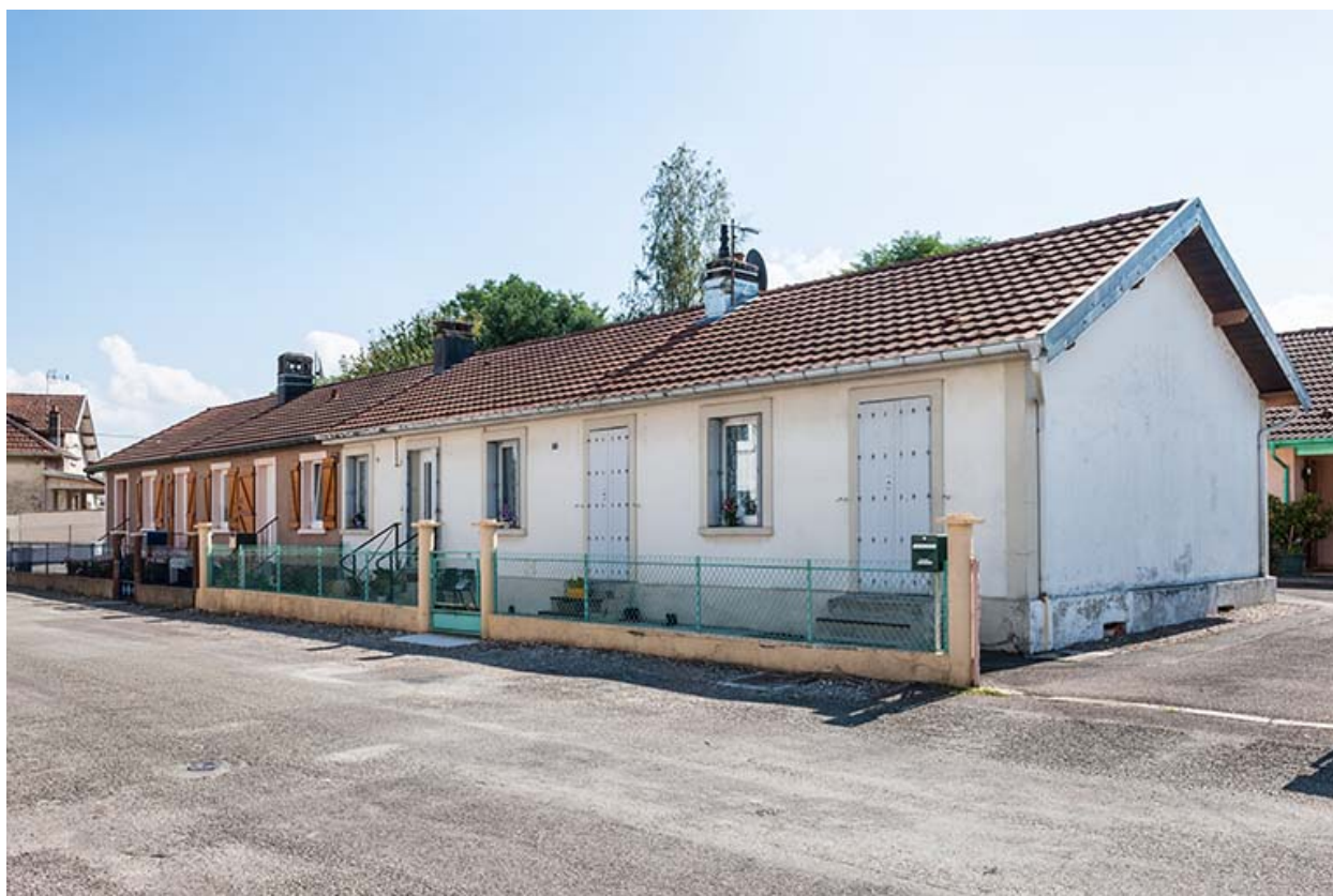
Habitation en rez-de-chaussée (4 logements).
