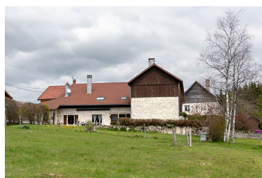
Façade latérale droite. Phot. Sonia Dourlot IVR43_20192500349NUC4A
