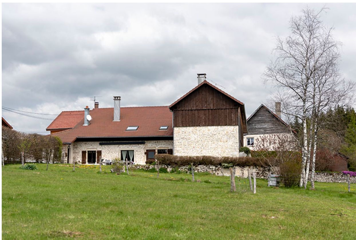
Façade latérale droite.
