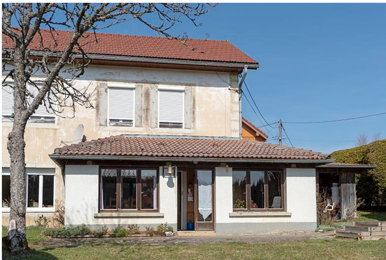
Façade postérieure : extension orientale.
