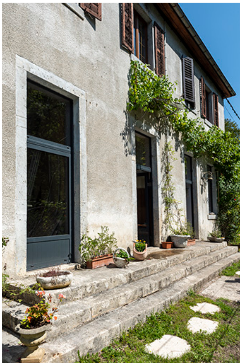
Façade antérieure et perron, vus en enfilade.
