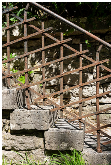
Garde-corps de l'escalier indépendant. Phot. Sonia Dourlot IVR43_20192501468NUC4A
