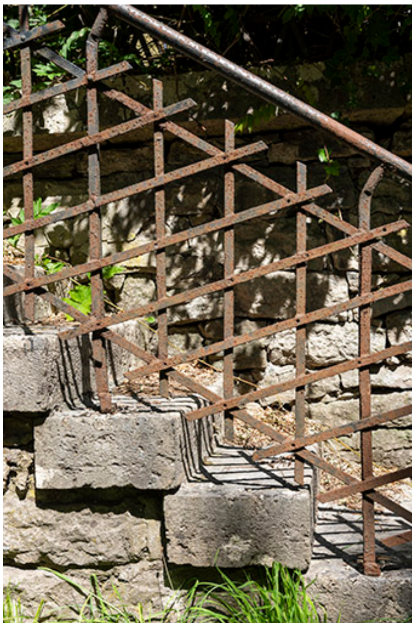
Garde-corps de l'escalier indépendant.
