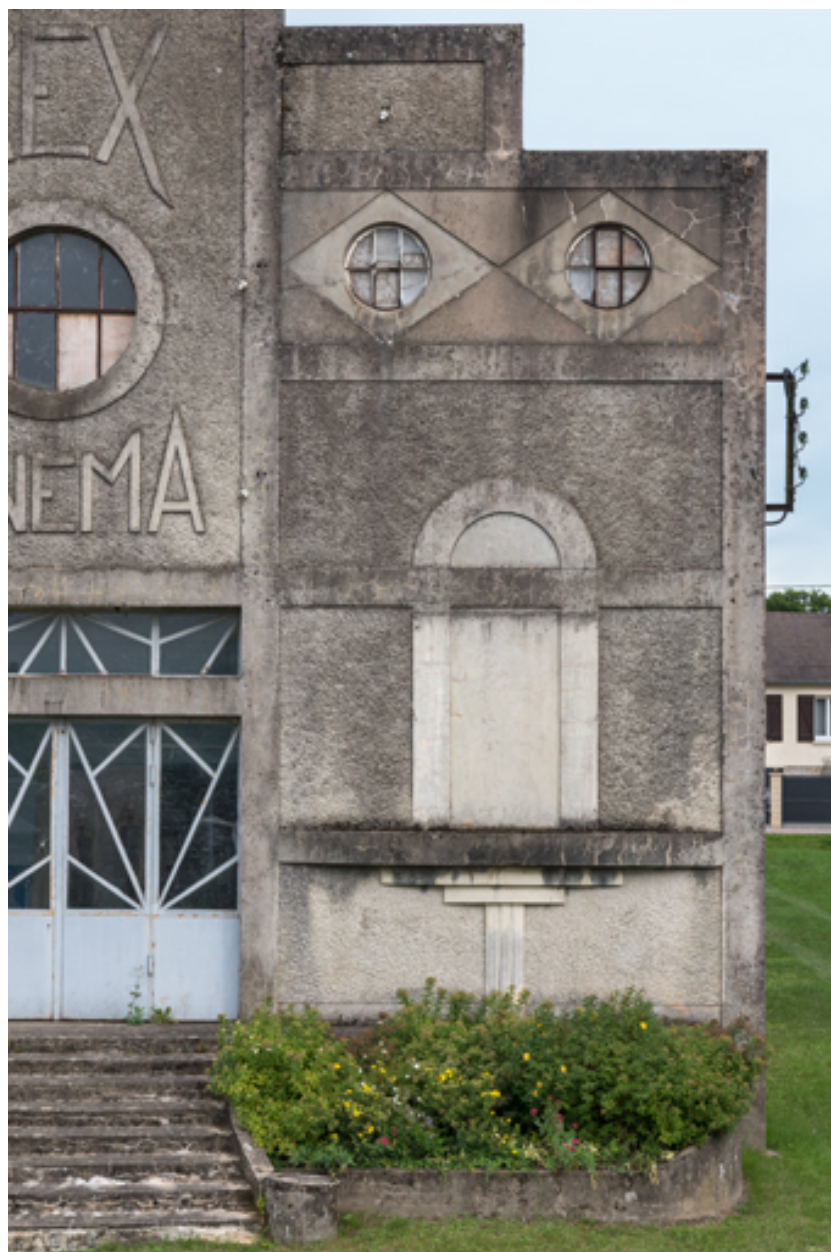
Façade antérieure : travée à droite.
