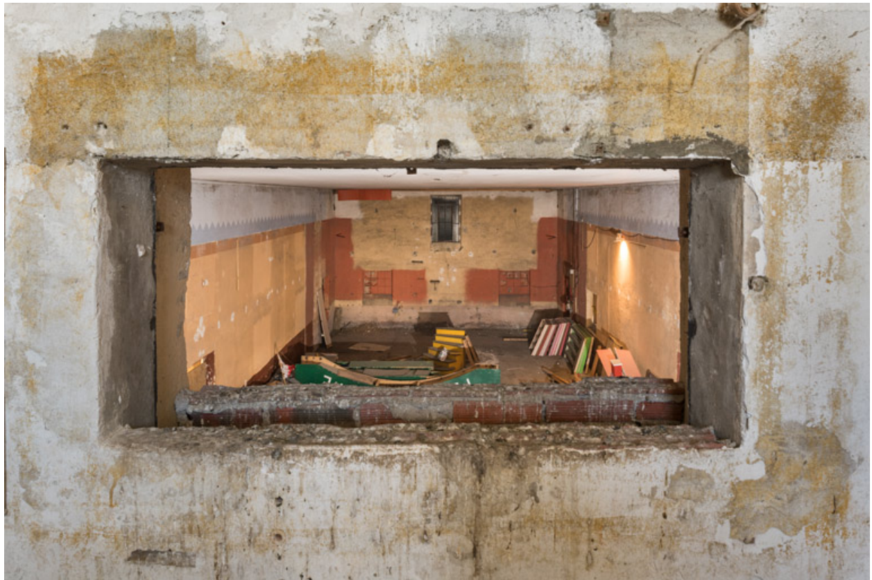
Salle, vue de la cabine du projectionniste.
