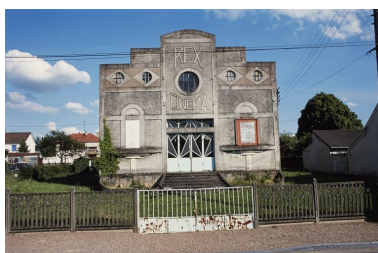
Élévation principale, en 2000. Phot. Jean-Luc Duthu IVR26_20005800122ZA
