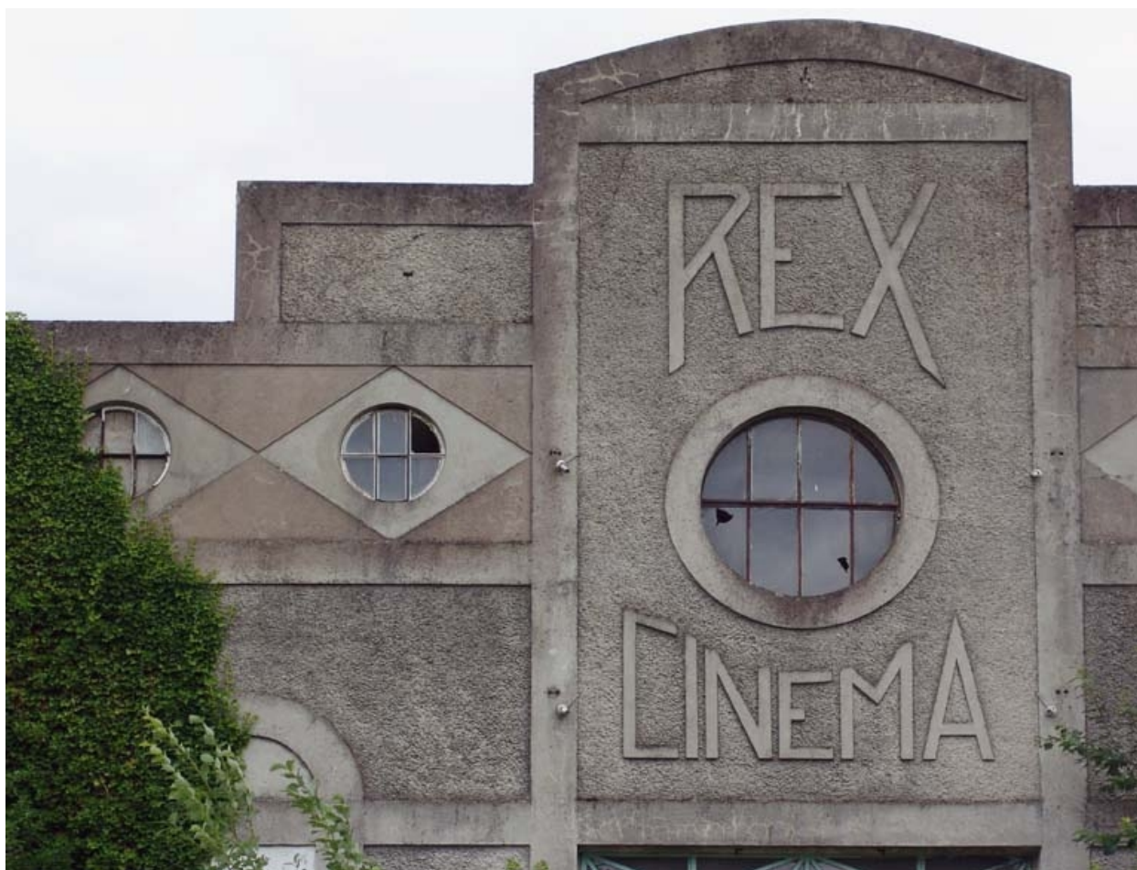
Elévation principale, en 2005 : décor en partie haute.
