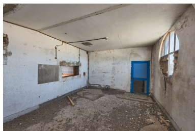
Cabine du projectionniste. Phot. Pierre-Marie Barbe-Richaud IVR26_20235800174NUC4A
