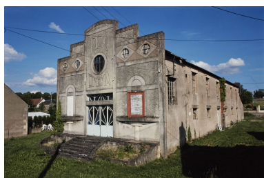
Elévation principale et latérale droite (en 2000), vue de trois-quarts. Phot. Jean-Luc Duthu IVR26_20005800123ZA
