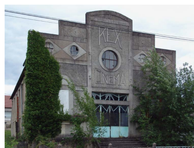
Élévation principale, en 2005. Phot. Alain Morelière IVR26_20055801106NUC2A
