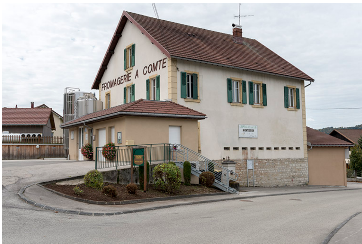
Façades antérieure et latérale droite.
