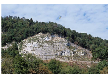
Sécurisation de paroi rocheuse à Syam : transport par hélicoptère d'un rouleau de filet de protection.
