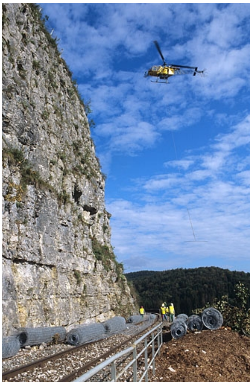
Sécurisation de paroi rocheuse à Syam : hélicoptère venant chercher un rouleau de filet de protection.
