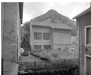
Façade postérieure du premier atelier. Phot. Jérôme Mongreville IVR43_19923900620X
