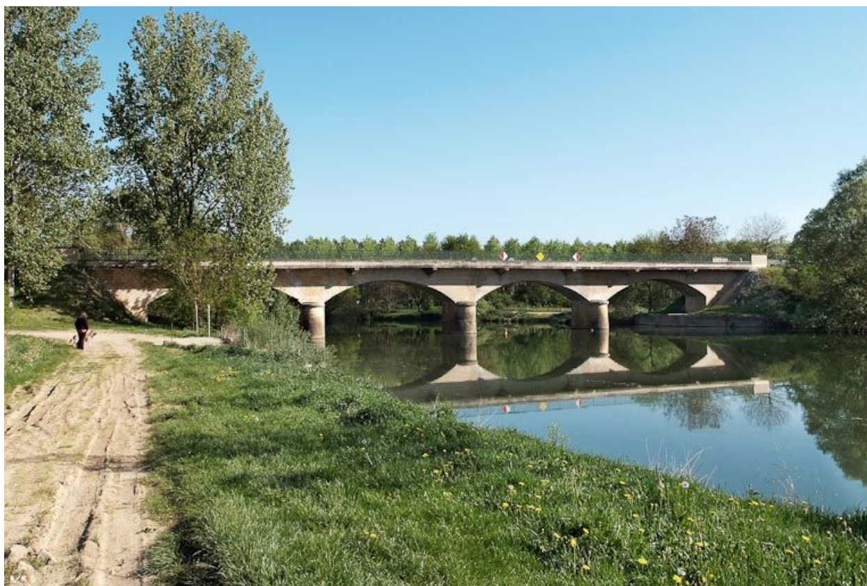
Pont vu d'amont.
