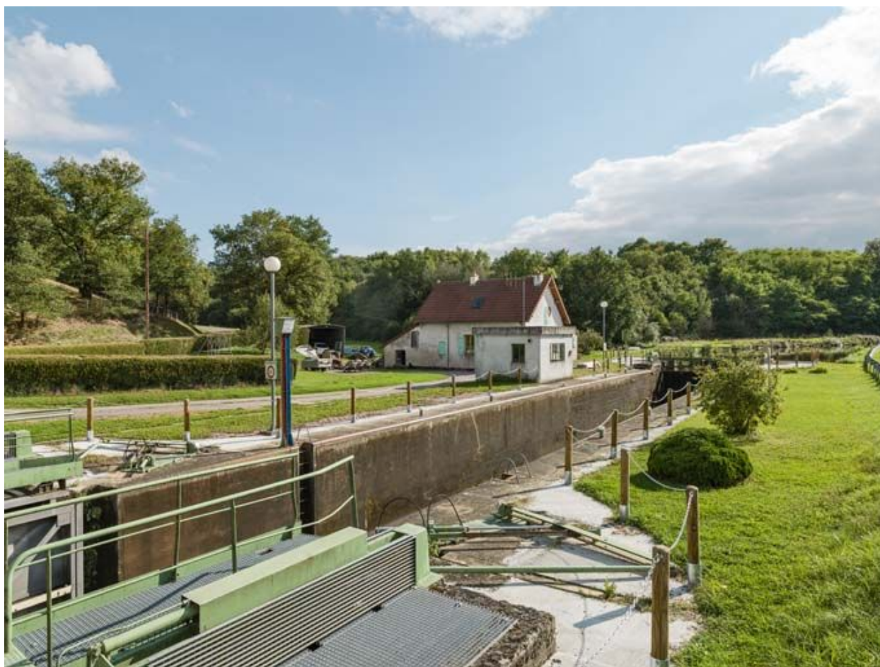
Vue d'ensemble du site d'écluse.
