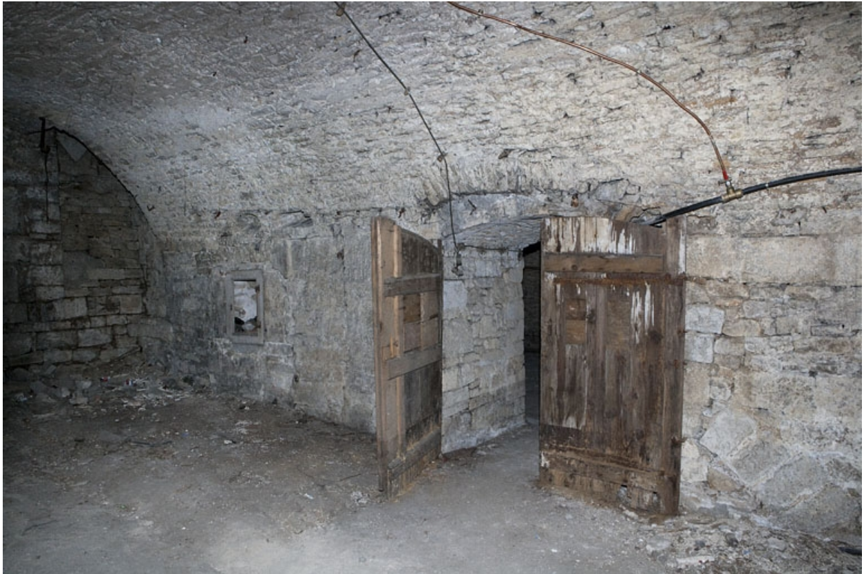
Logis principal, sous-sol : cave C.
