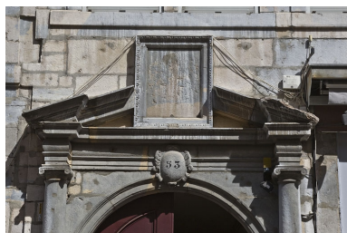
Façade antérieure du logis principal, portail d'entrée : détail du fronton interrompu à tabernacle. Phot. Yves Sancey IVR43_20112500690NUC2A
