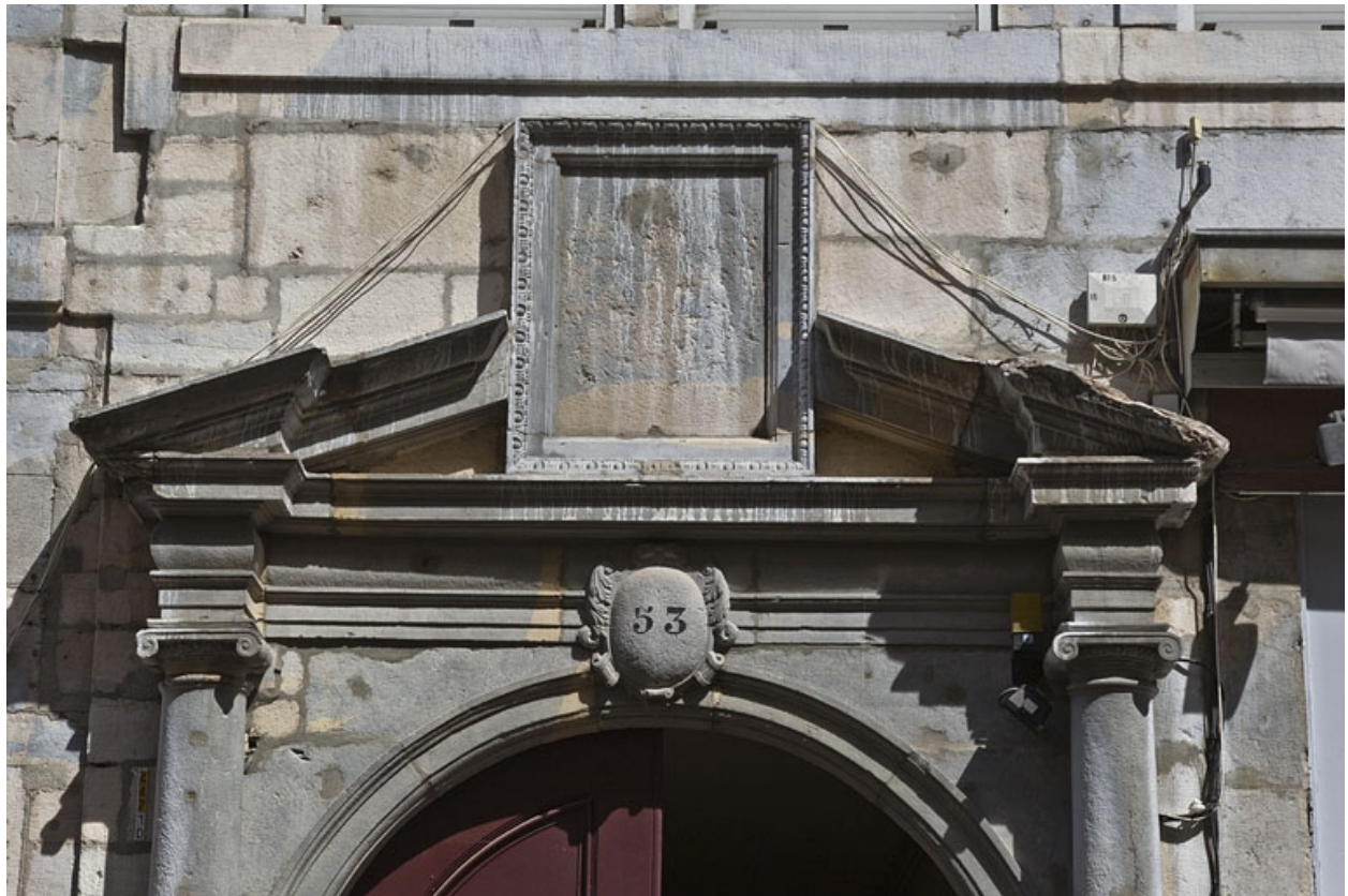
Façade antérieure du logis principal, portail d'entrée : détail du fronton interrompu à tabernacle.
