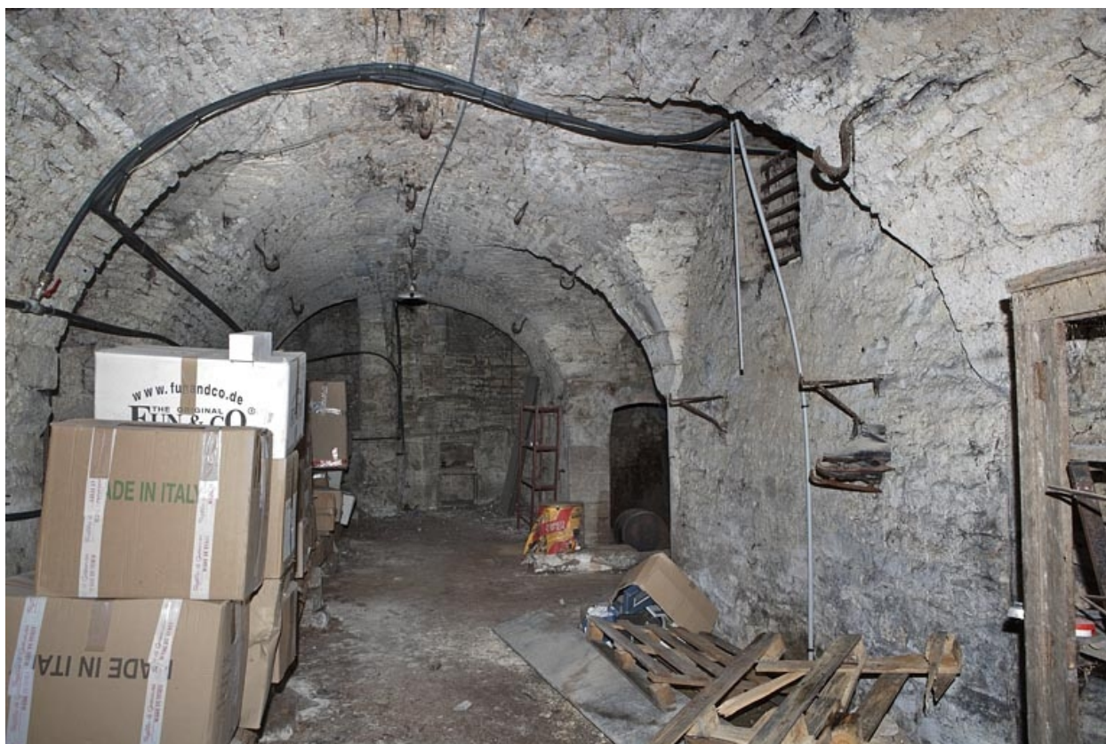
Logis principal, sous-sol : cave A depuis l'entrée.
