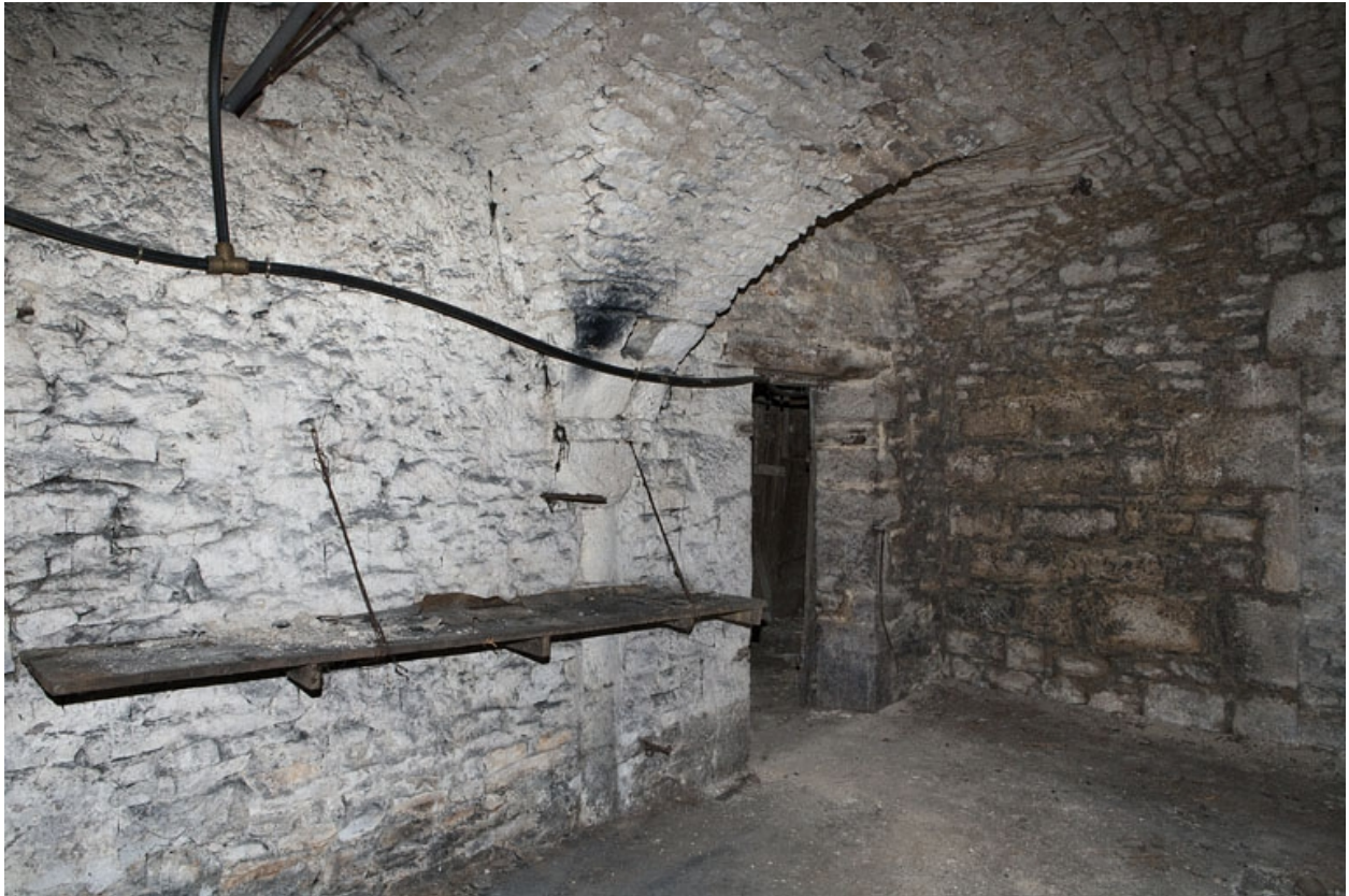
Logis principal, sous-sol : cave C.
