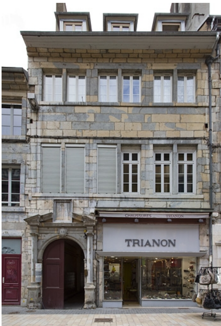
Façade antérieure du logis principal : de face.
