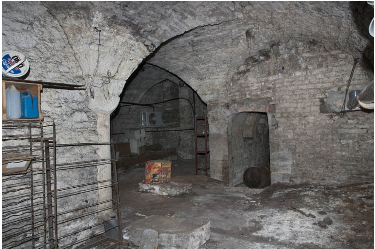
Logis principal, sous-sol : cave A, vue d'ensemble.
