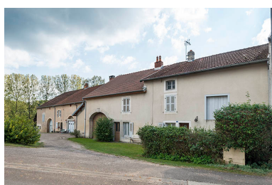
Vue depuis la Grande rue. Phot. Jérôme Mongreville IVR43_20167001622NUC4A
