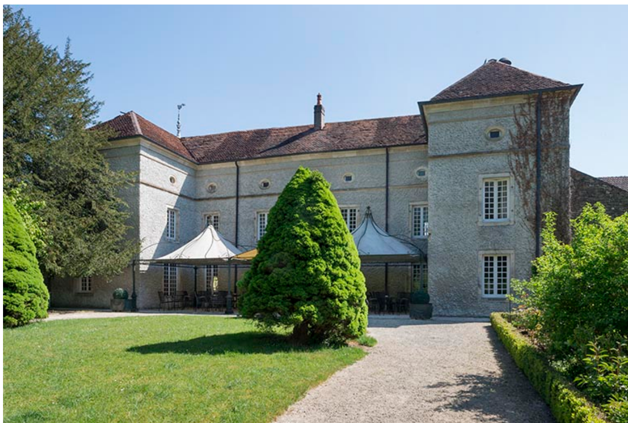
Vue générale, façade postérieure.
