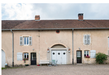
Ferme à deux travées. Phot. Jérôme Mongreville IVR43_20167001620NUC4A
