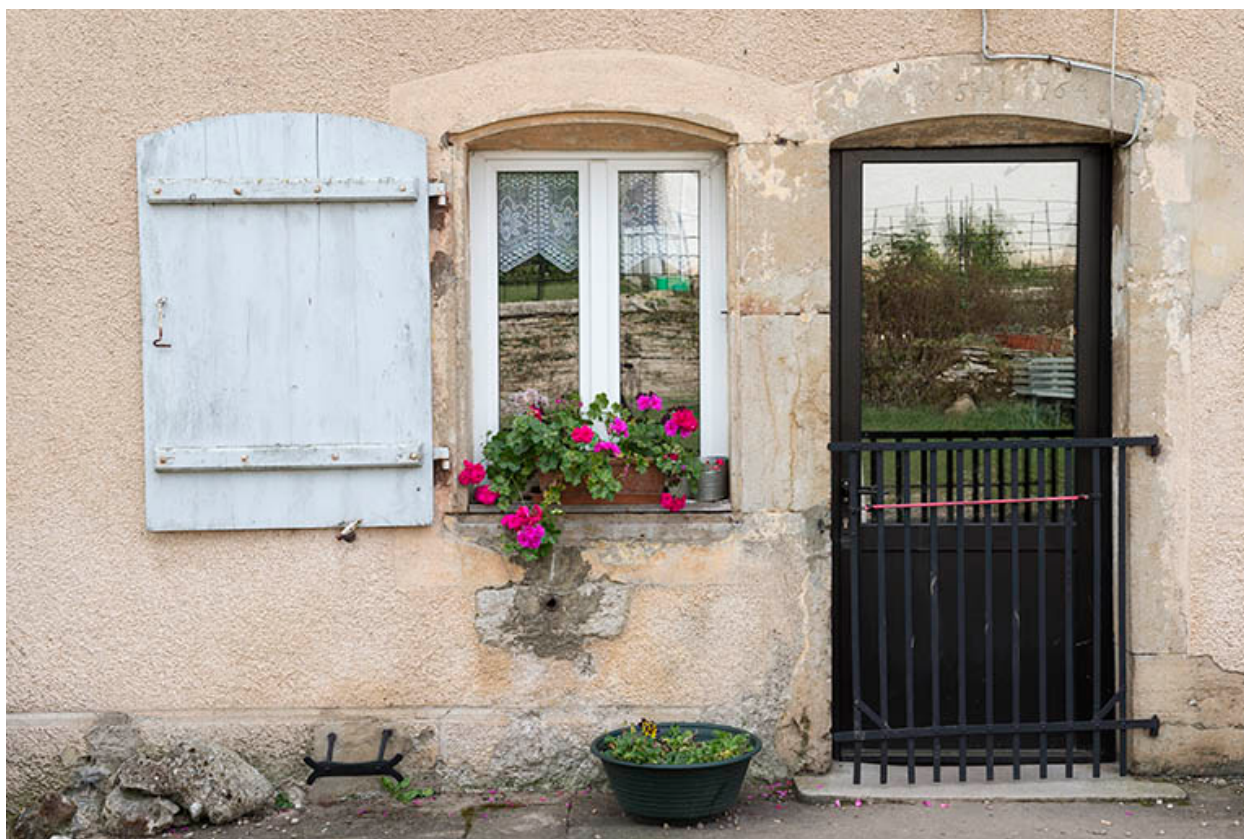
Détail, porte d'entrée de la partie habitation.
