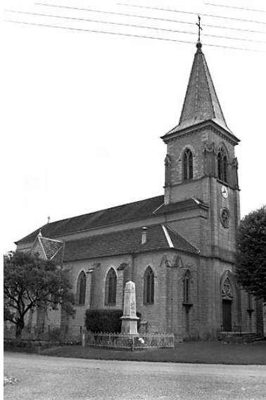
Façades antérieure et latérale gauche.
