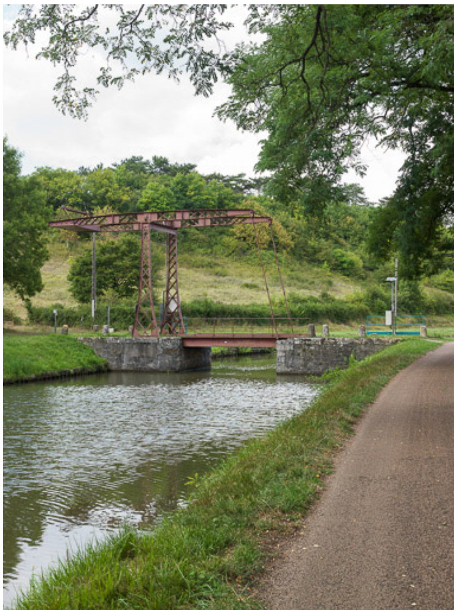
Vue d'ensemble du pont.
