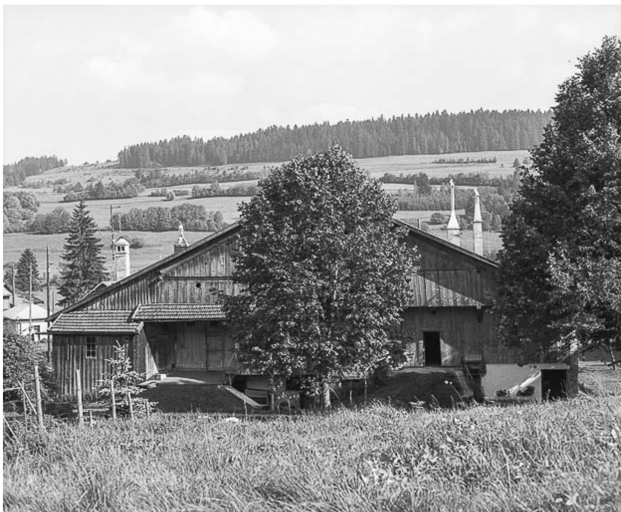
Façade postérieure en 1976.
