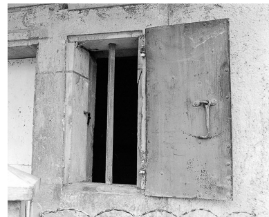
La "voûte" en 1977, façade antérieure : volet ouvert. Phot. Yves Sancey IVR43_19772500324X
