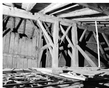
Intérieur en 1977, combles : fermes de charpente jumelées, en arrière des "tués", au niveau d'une panne. Phot. Yves Sancey IVR43_19772500335X
