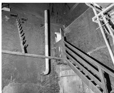
Intérieur en 1977, "tué" droit : porte en haut de l'escalier et support des perches servant au fumage de la viande. Phot. Yves Sancey IVR43_19772500342X
