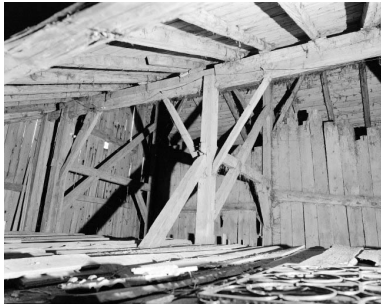
Intérieur en 1977, combles : fermes de charpente postérieures. Phot. Yves Sancey IVR43_19772500333X
