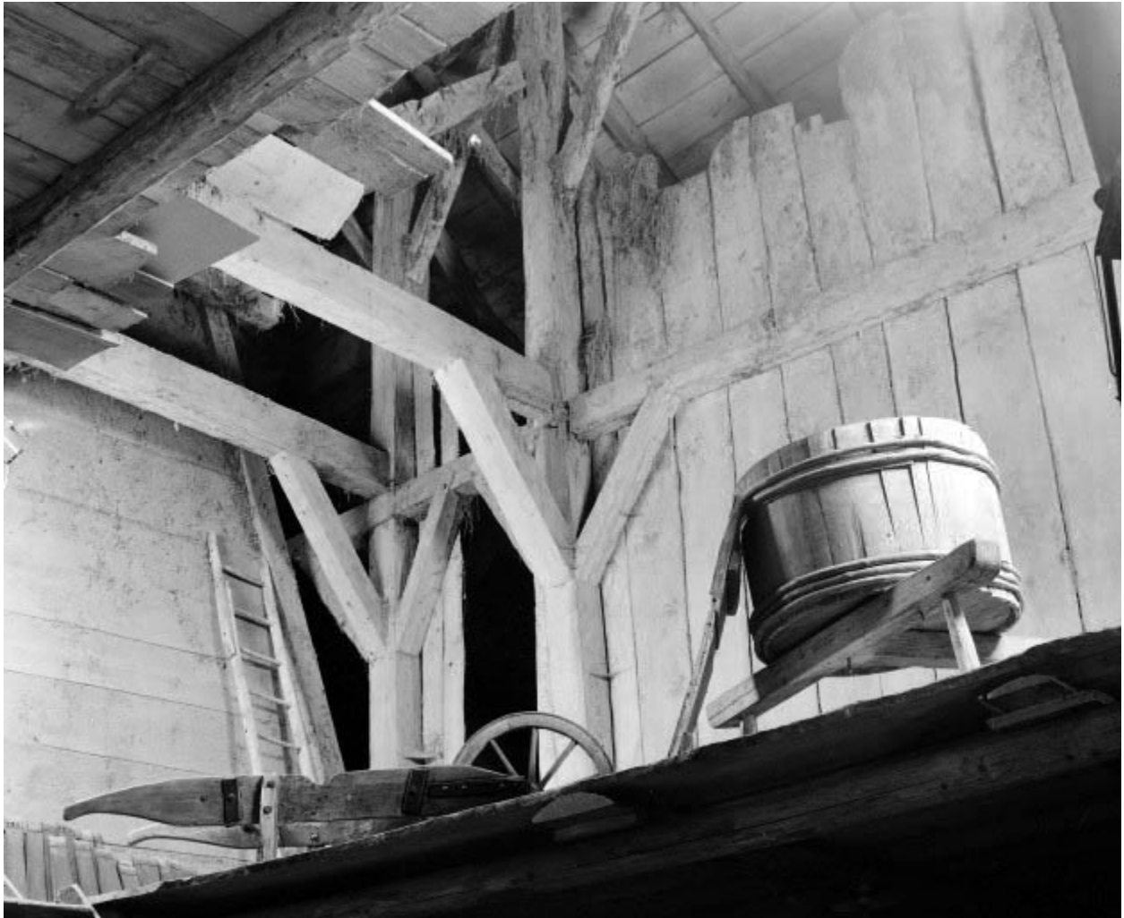
Intérieur en 1977, combles : fermes de charpente jumelées, en arrière des "tués", au niveau de la faîtière.
