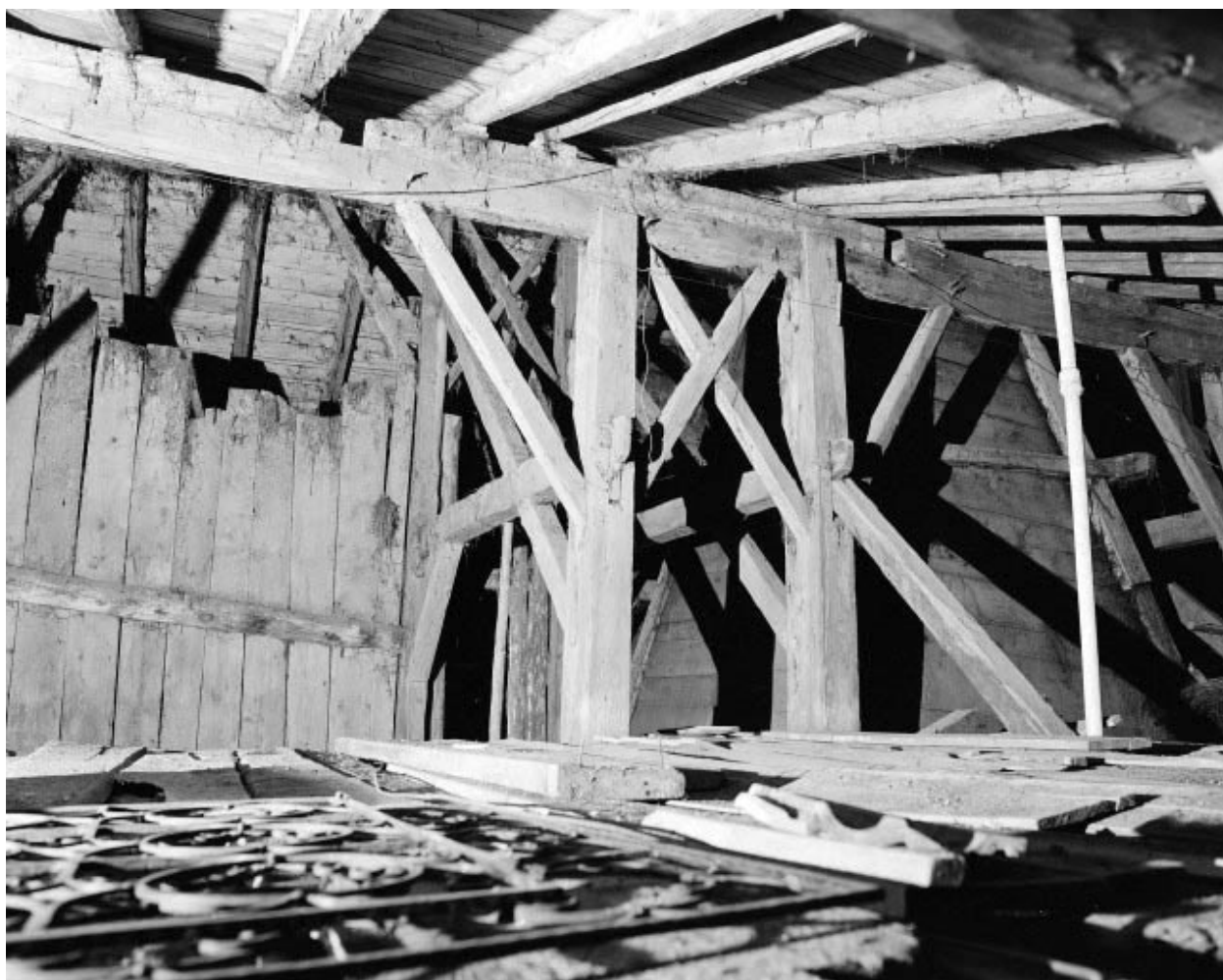
Intérieur en 1977, combles : fermes de charpente jumelées, en arrière des "tués", au niveau d'une panne.
