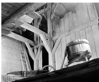
Intérieur en 1977, combles : fermes de charpente jumelées, en arrière des "tués", au niveau de la faîtière. Phot. Yves Sancey IVR43_19772500332X
