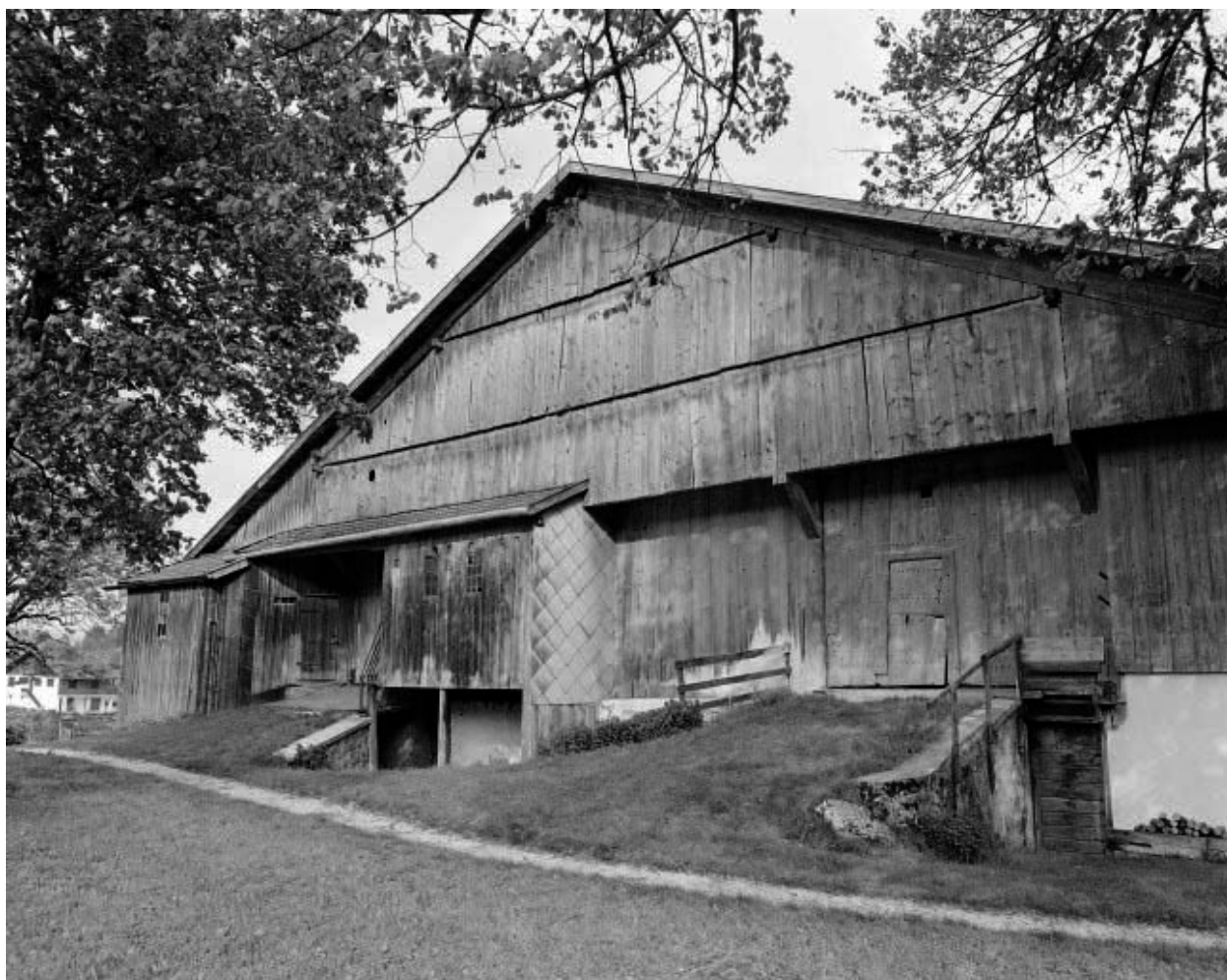
Façade postérieure en 1977, de trois quarts droite.
