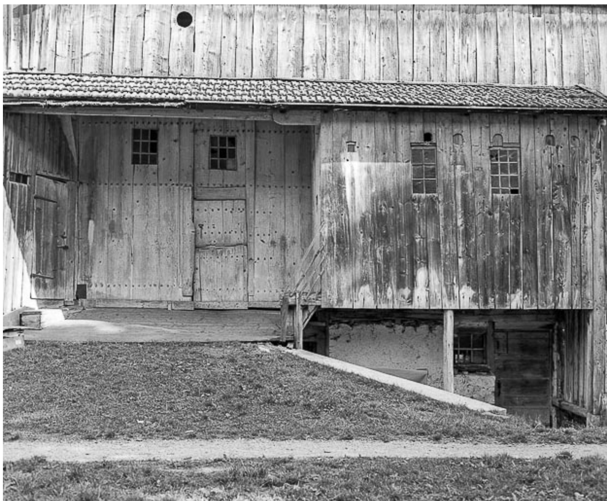
Façade postérieure en 1976 : détail.
