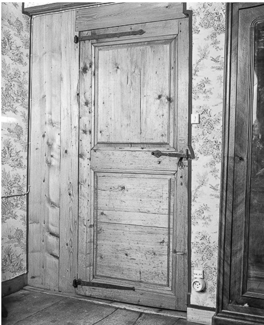
Intérieur en 1977 : porte en résineux.
