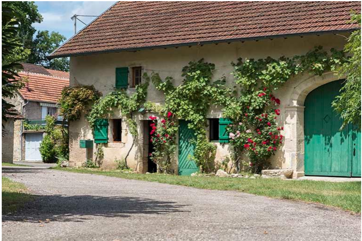
Vue extérieure de l'écurie et du grangage
