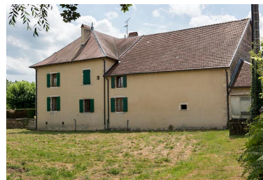
Façade arrière donnant sur le Durgeon Phot. Sonia Dourlot IVR43_20167001136NUC4A
