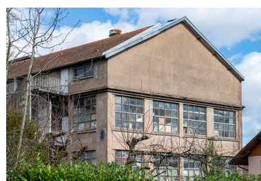
Pignon sud de l'entrepôt industriel. Phot. Jérôme Mongreville IVR43_20192500127NUC4A
