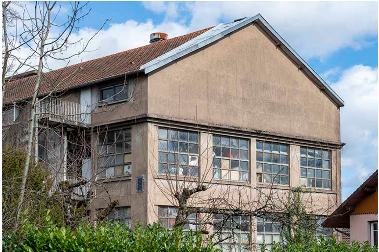
Pignon sud de l'entrepôt industriel.
