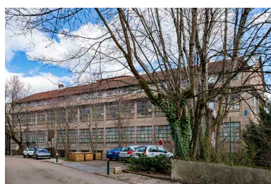
Façade ouest de l'entrepôt industriel. Phot. Jérôme Mongreville IVR43_20192500126NUC4A
