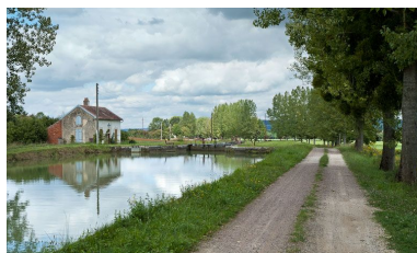
Vue du site d'écluse depuis l'amont. Phot. Pierre-Marie Barbe-Richaud IVR26_20112103968NUC4AQ
