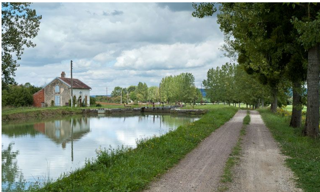
Vue du site d'écluse depuis l'amont.
