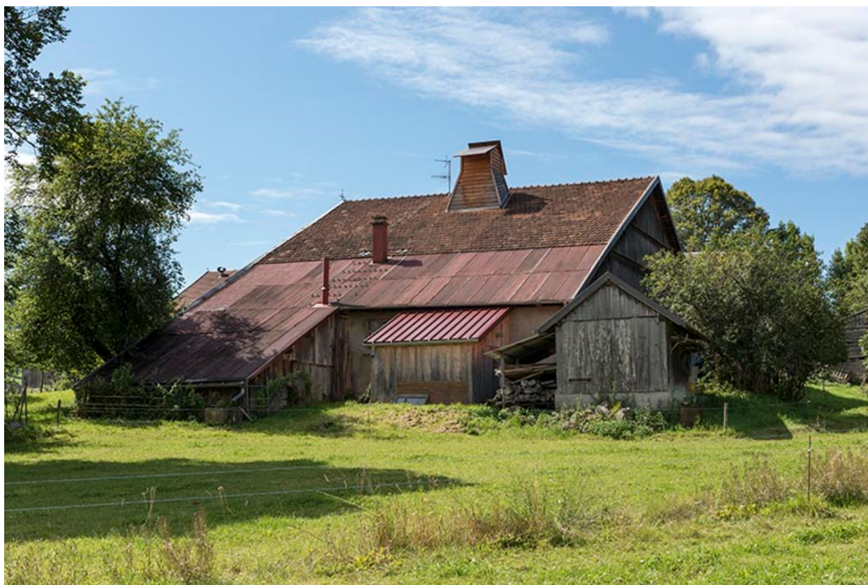
Façades latérale droite et postérieure.
