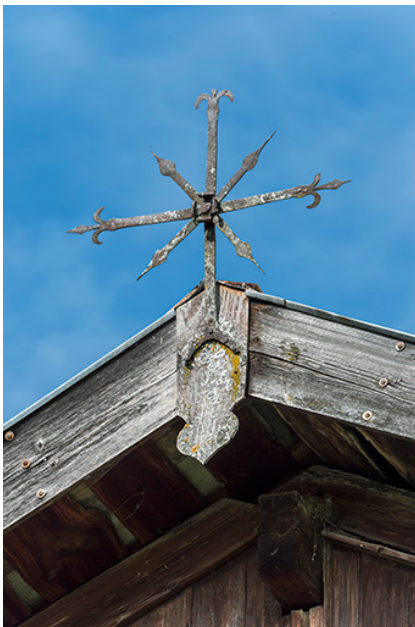
Façade antérieure : croix de faîtage.
