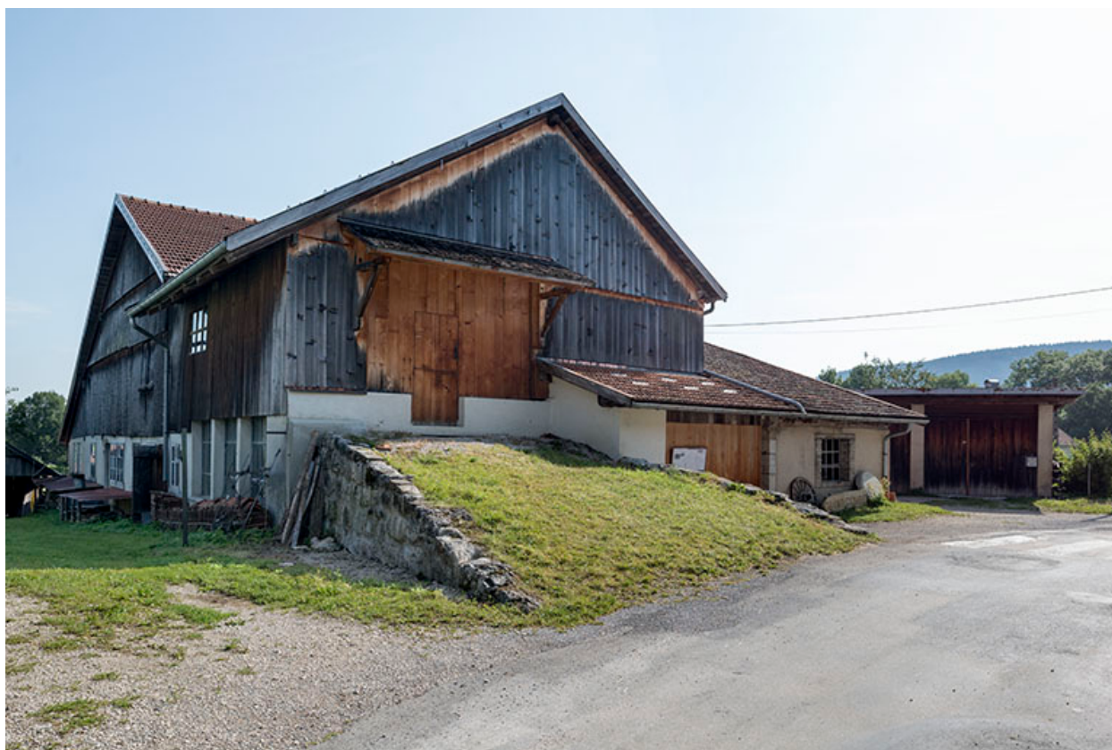
Façades latérale gauche et postérieure.
