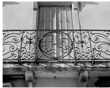
Façade antérieure, détail du balcon. Phot. Yves Sancey IVR43_19833900636X
