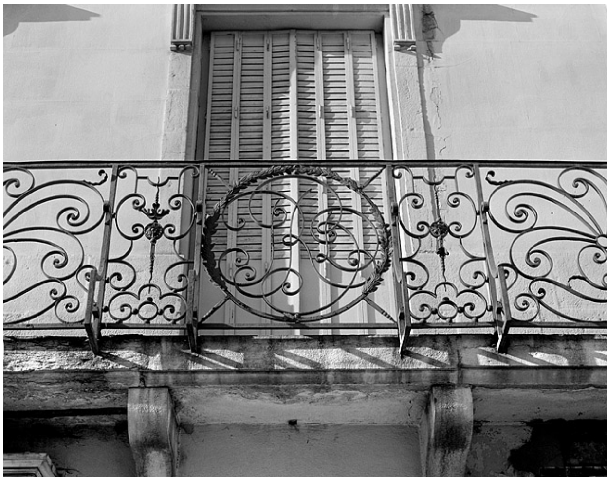
Façade antérieure, détail du balcon.
