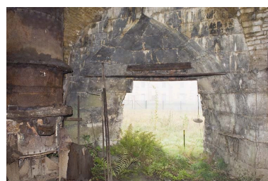
Cubilot est et embrasure appareillée (vestige du haut fourneau). Phot. Jérôme Mongreville IVR43_20087000960NUC2A
