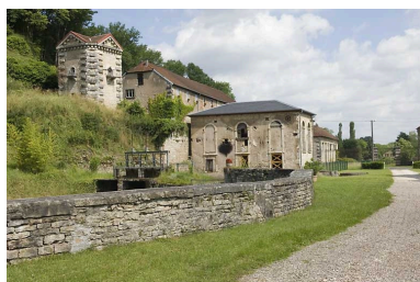
Pigeonnier, halle à charbon et salle des machines depuis l'est. Phot. Jérôme Mongreville IVR43_20087000642NUC2A
