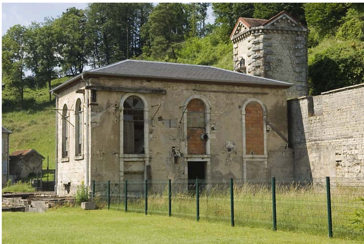
Façade ouest de la salle des machines.
