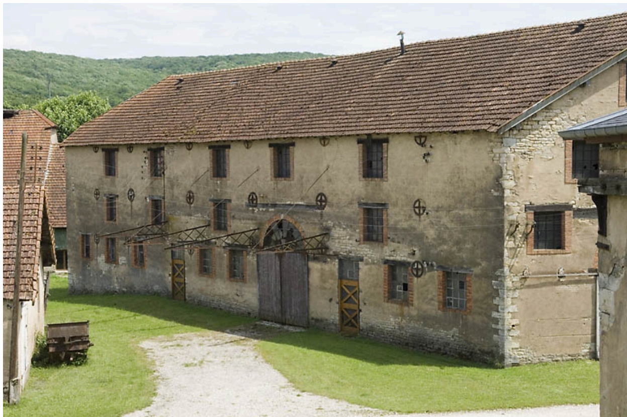
Façade ouest du magasin industriel (fonderie).
