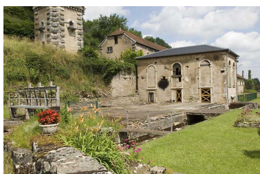
Salle des machines depuis l'est. Phot. Jérôme Mongreville IVR43_20087000650NUC2A
