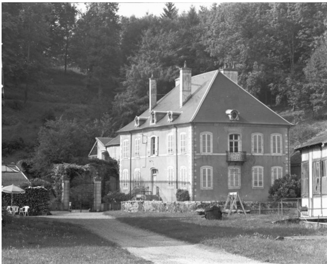
Le logement patronal vu de trois quarts en 1992.
