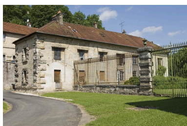
Logement (ancienne orangerie) vu depuis la cour. Phot. Jérôme Mongreville IVR43_20087000635NUC2A
