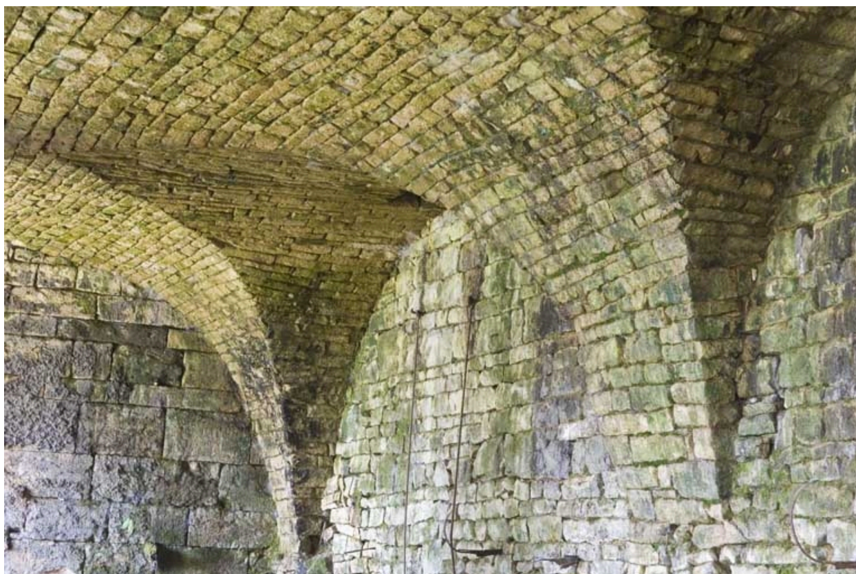
Salle des cubilots. Détail des voûtes d'arêtes.
