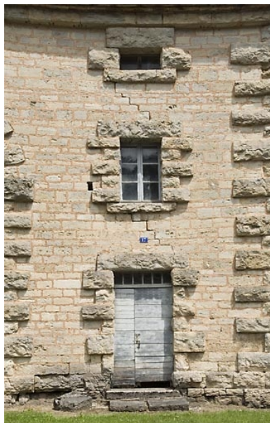
Magasin en quart de cercle. Elévation d'une travée. Phot. Jérôme Mongreville IVR43_20087000667NUC2A
