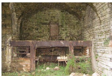
Salle des cubilots. Vestiges d'un four (?). Phot. Jérôme Mongreville IVR43_20087000966NUC2A
