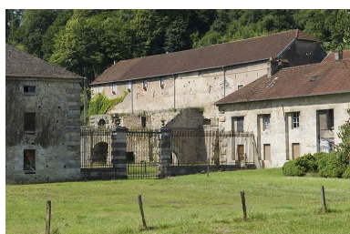
Vue rapprochée depuis le nord-ouest. Phot. Jérôme Mongreville IVR43_20087000633NUC2A
