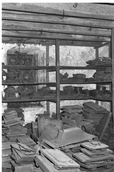
Modèles et planches de moulage d'éléments de fourneaux et de cuisinières. Phot. Dominique Dominguez IVR43_19817000054Z
