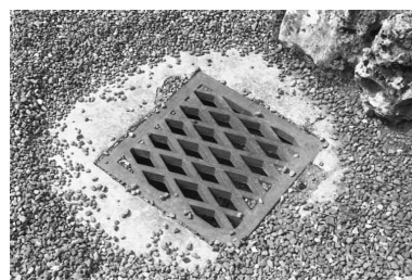
Grille d'égout. Phot. Dominique Dominguez IVR43_19817000042Z
