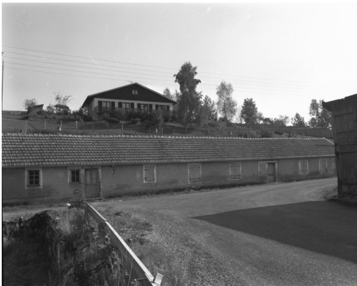
Façade ouest du logement ouvrier de la forge de Petit Baignes en 1989.
