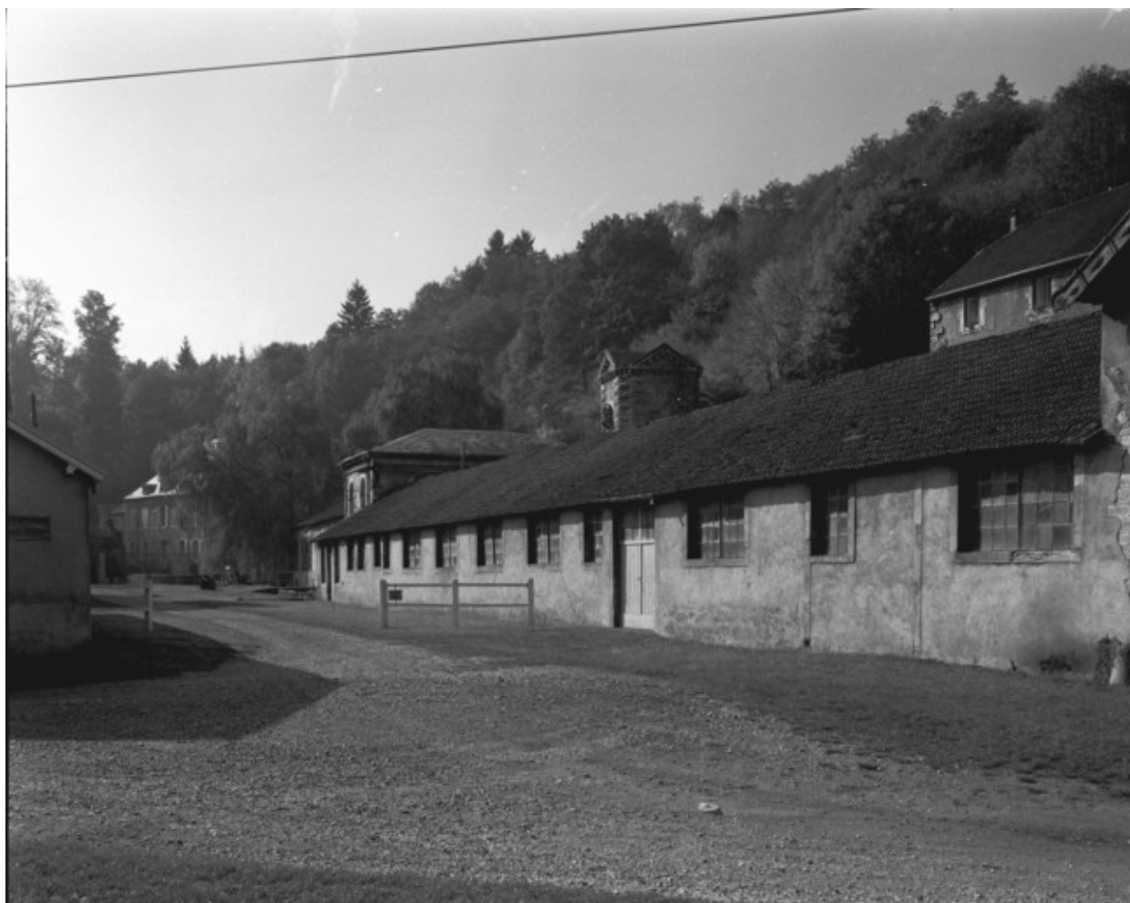
Façade est de l'atelier de fonderie en 1989.
