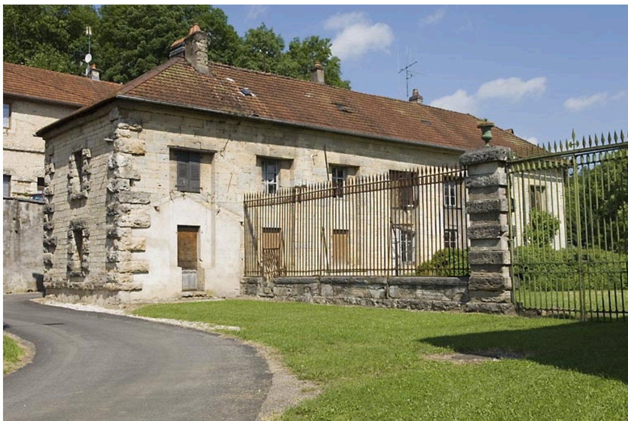
Logement (ancienne orangerie) vu depuis la cour.
