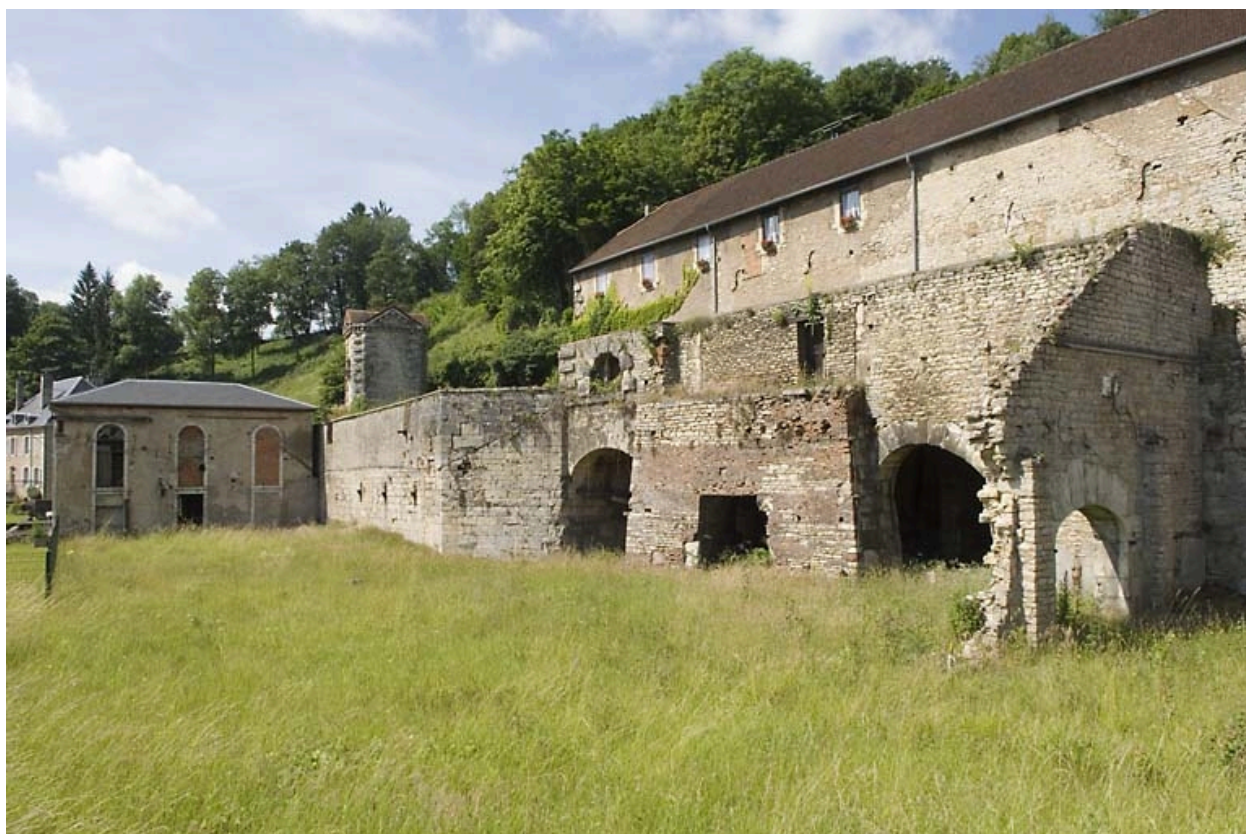
Vestiges du haut fourneau. Au premier plan : emplacement de l'atelier de fonderie.
