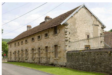
Logement ouvrier est bordant la rue. Phot. Jérôme Mongreville IVR43_20087000668NUC2A
