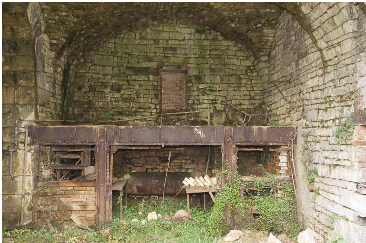
Salle des cubilots. Vestiges d'un four (?).
