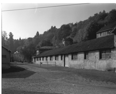
Façade est de l'atelier de fonderie en 1989. Phot. Yves Sancey IVR43_19897000695X
