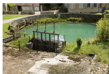
Le bassin de la source et le vannage. Phot. Jérôme Mongreville IVR43_20087000661NUC2A
