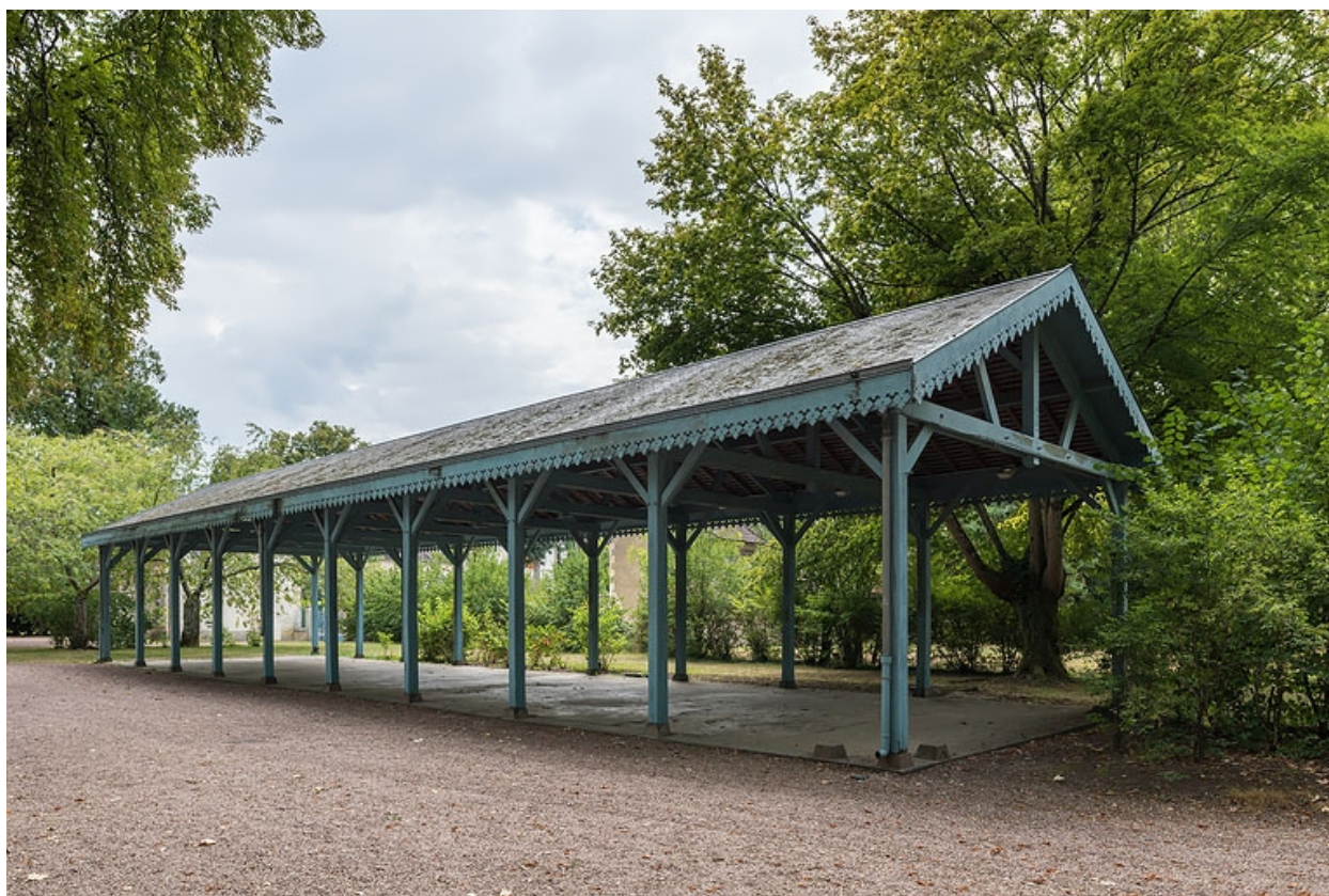
Allée couverte après reconstruction.
