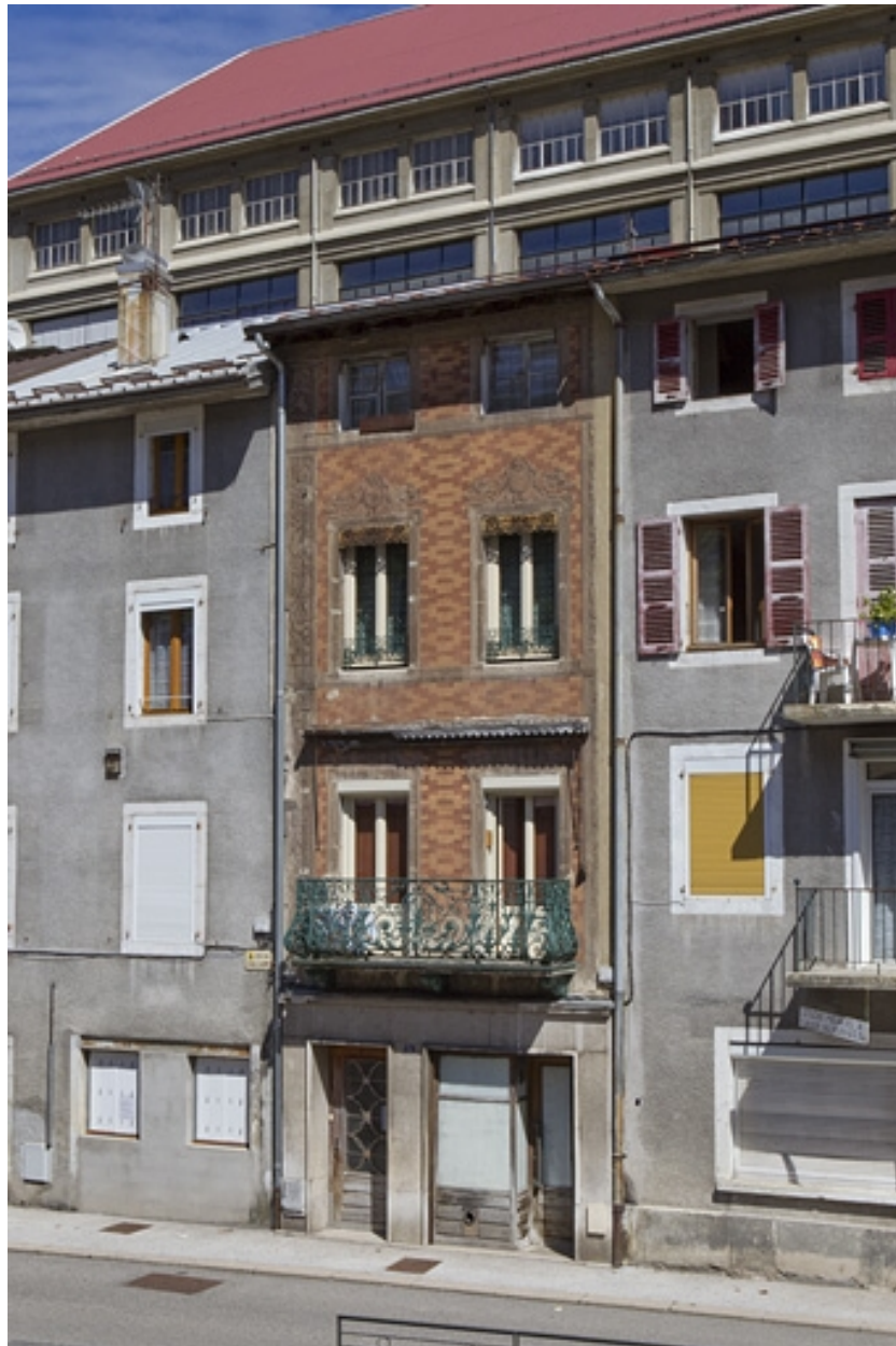
Elévation antérieure, de trois quarts droite.
