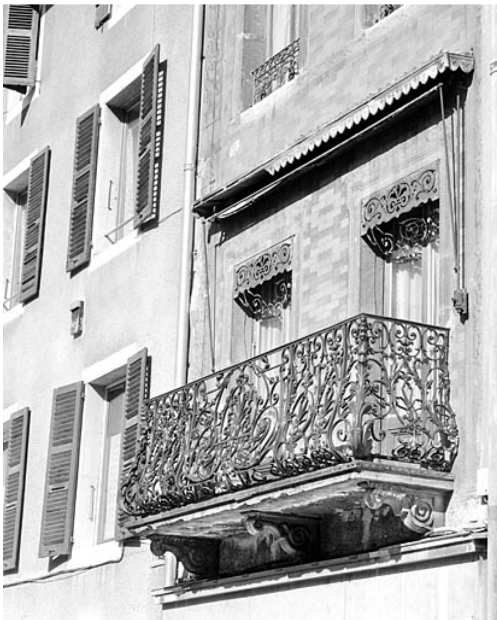
Balcon au premier étage.
