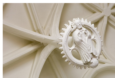
Détail de la clef de voûte. Phot. Jérôme Mongreville IVR43_20072500120NUCA
