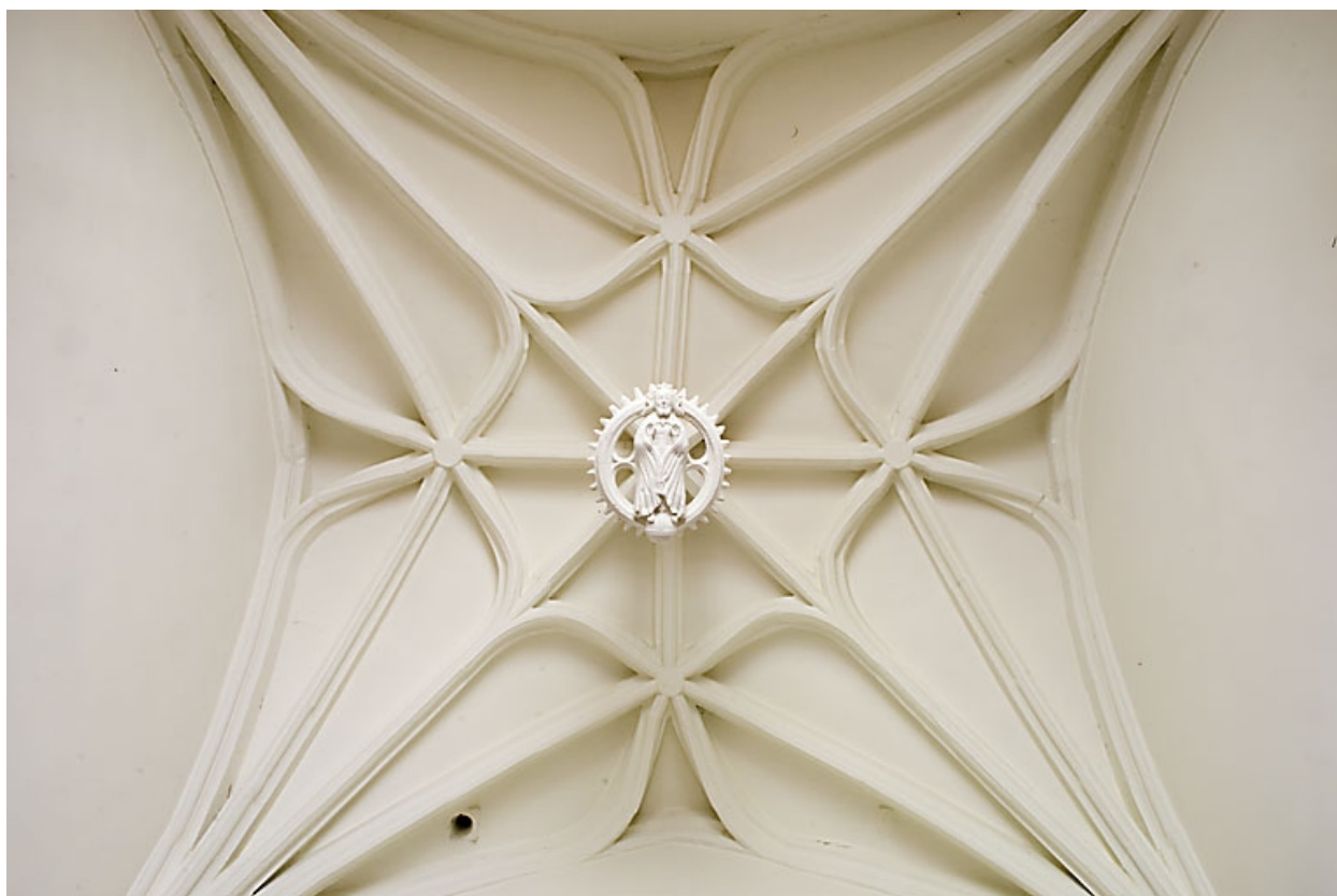
Voûte de la sacristie.
