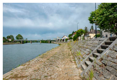
Le chemin de halage. Phot. Jérôme Mongreville IVR43_20197000374NUC4A
