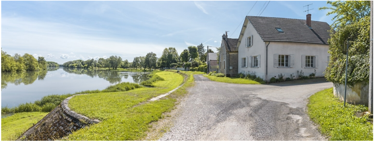
Tête aval de la digue.
