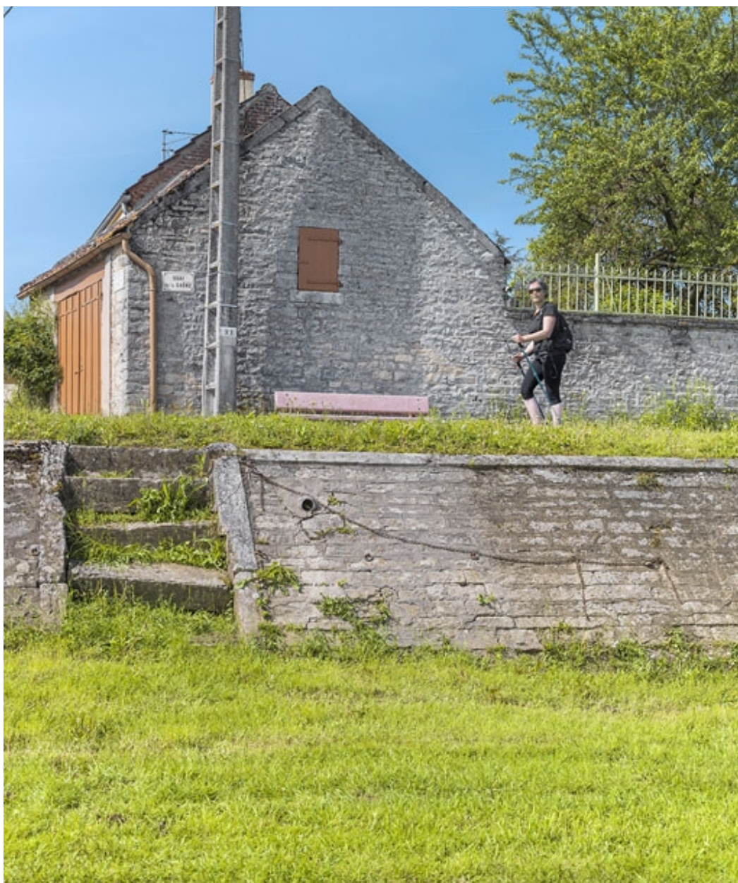
Escalier de sauvetage.
