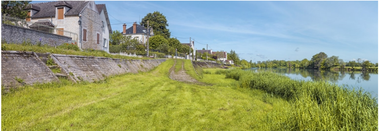
Escalier et digue en aval du ponceau.
