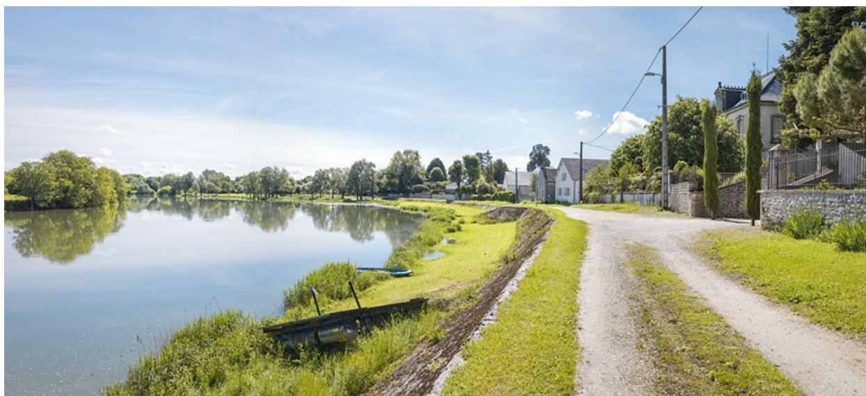
Vue d'ensemble de la digue, prise d'aval.
