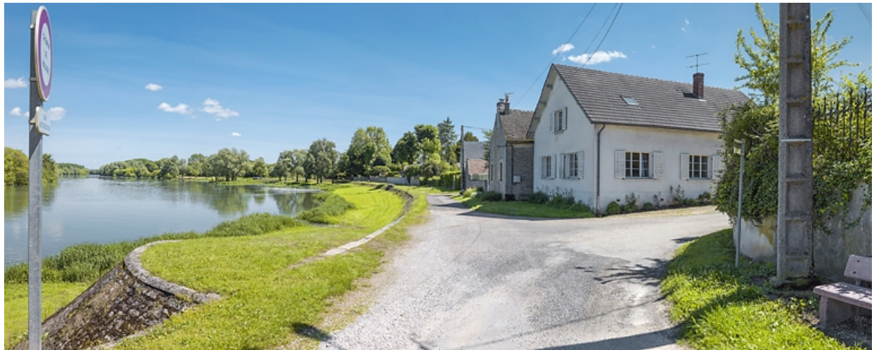
Tête aval de la digue.
