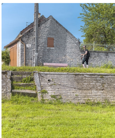
Escalier de sauvetage. Phot. Thierry Kuntz IVR26_20172100187NUC4A
