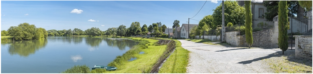
Vue d'ensemble de la digue, prise d'aval.
