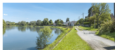
Vue d'ensemble de la digue, prise d'aval. Phot. Thierry Kuntz IVR26_20172100183NUC4A
