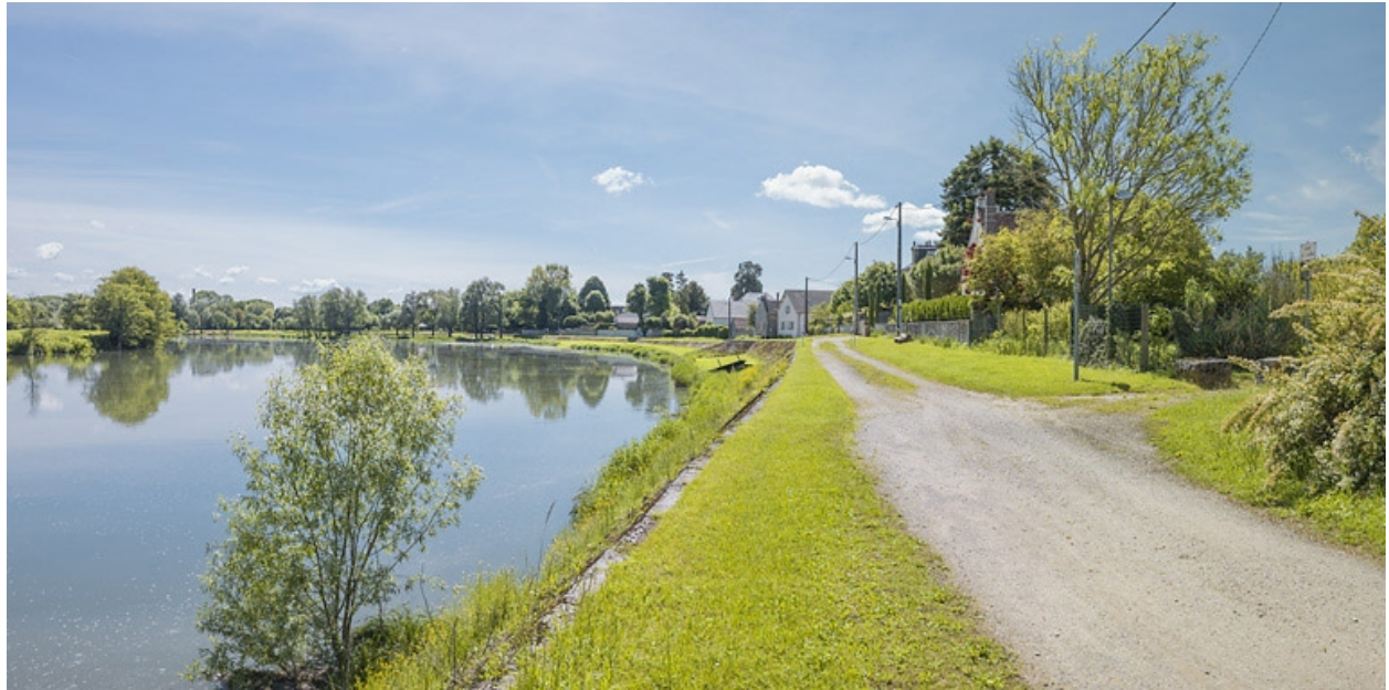
Vue d'ensemble de la digue, prise d'aval.
