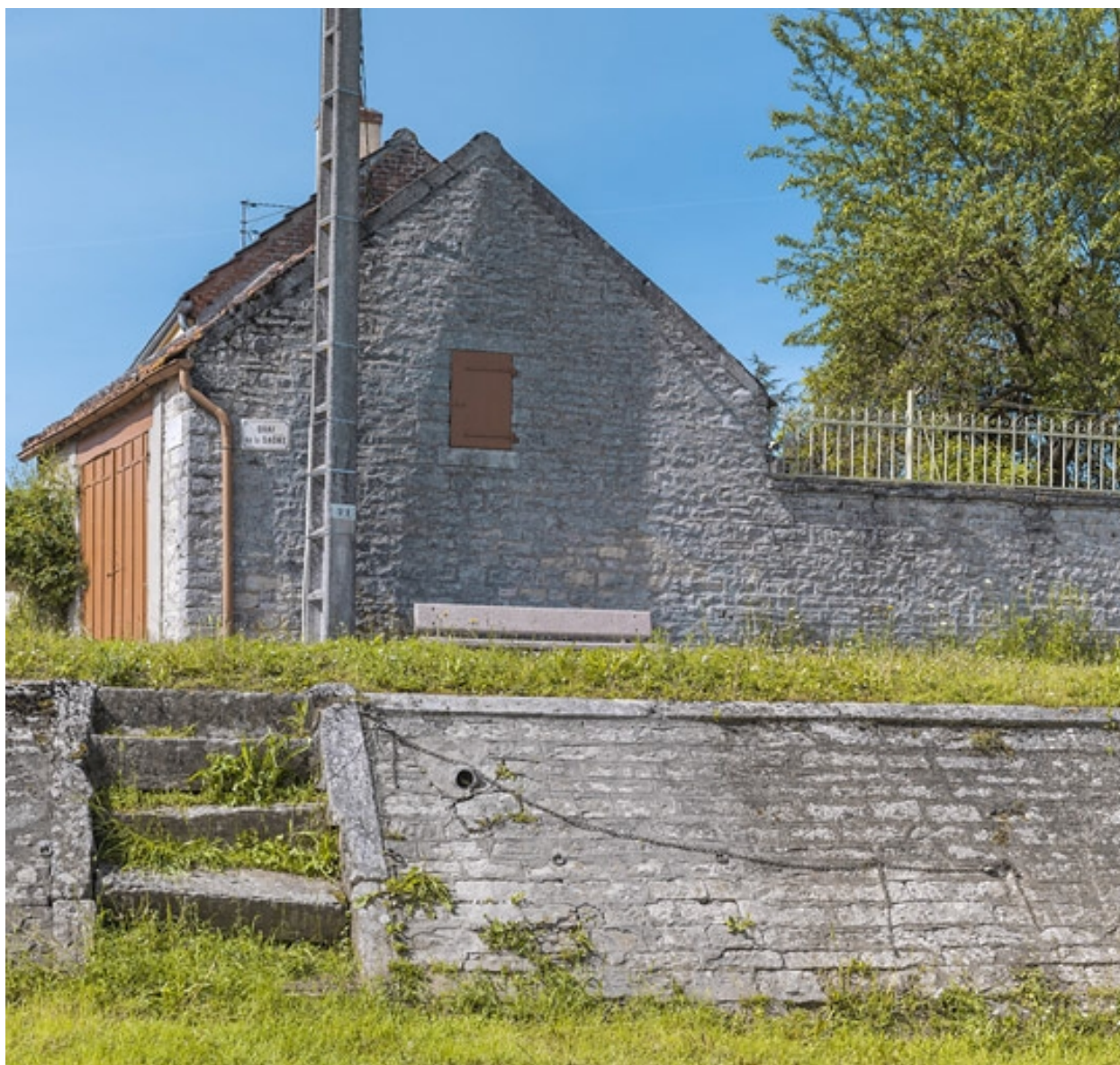
Escalier de sauvetage.
