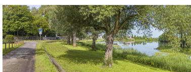
Digue et village. Phot. Thierry Kuntz IVR26_20172100203NUC4A
