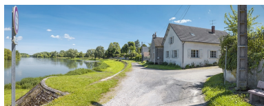
Tête aval de la digue. Phot. Thierry Kuntz IVR26_20172100181NUC4A
