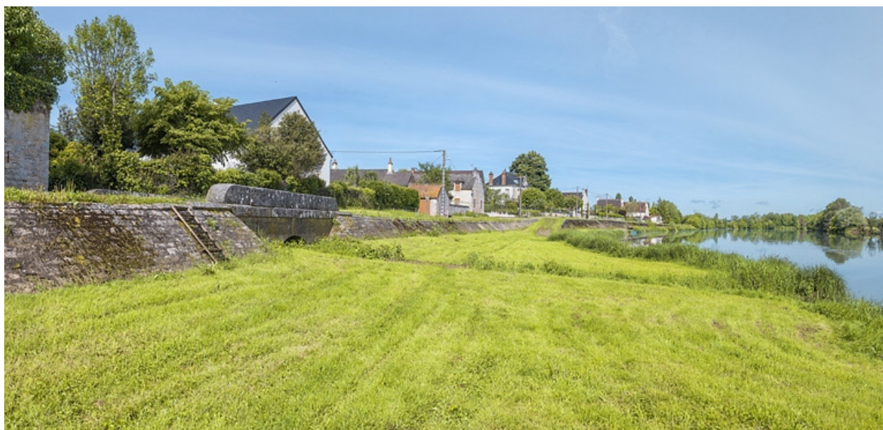
Ponceau au milieu de la digue.
