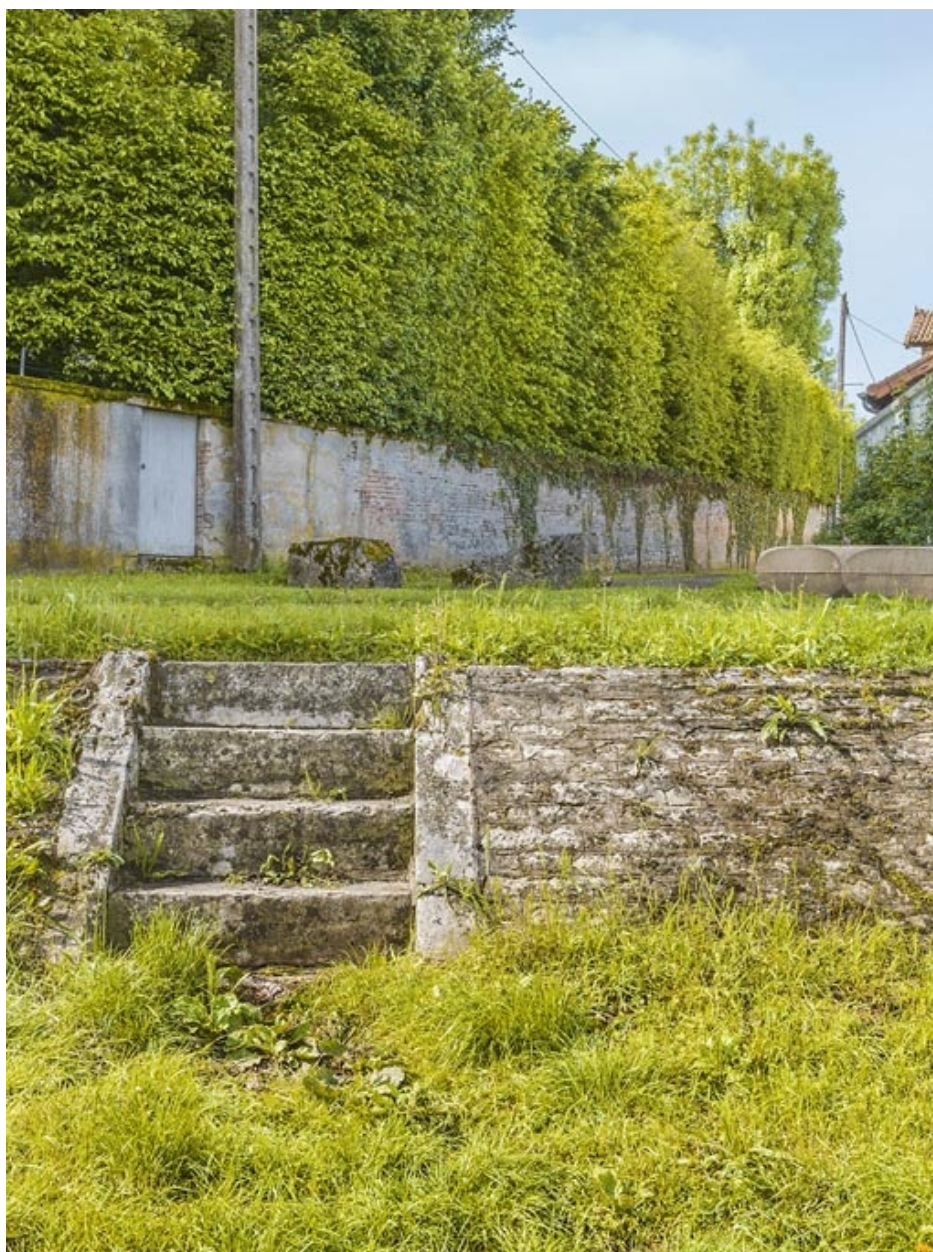
Deuxième escalier de la digue.
