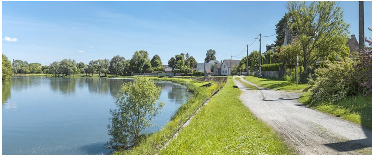
Vue d'ensemble de la digue, prise d'aval.
