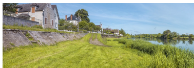
Escalier et digue en aval du ponceau. Phot. Thierry Kuntz IVR26_20172100198NUC4A
