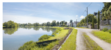
Vue d'ensemble de la digue, prise d'aval. Phot. Thierry Kuntz IVR26_20172100205NUC4A
