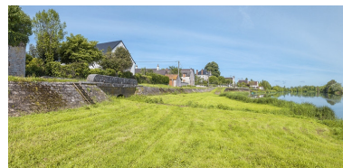
Ponceau au milieu de la digue. Phot. Thierry Kuntz IVR26_20172100199NUC4A
