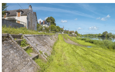
Escalier et rampe de la digue. Phot. Thierry Kuntz IVR26_20172100186NUC4A
