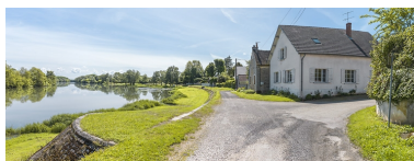
Tête aval de la digue. Phot. Thierry Kuntz IVR26_20172100211NUC4A
