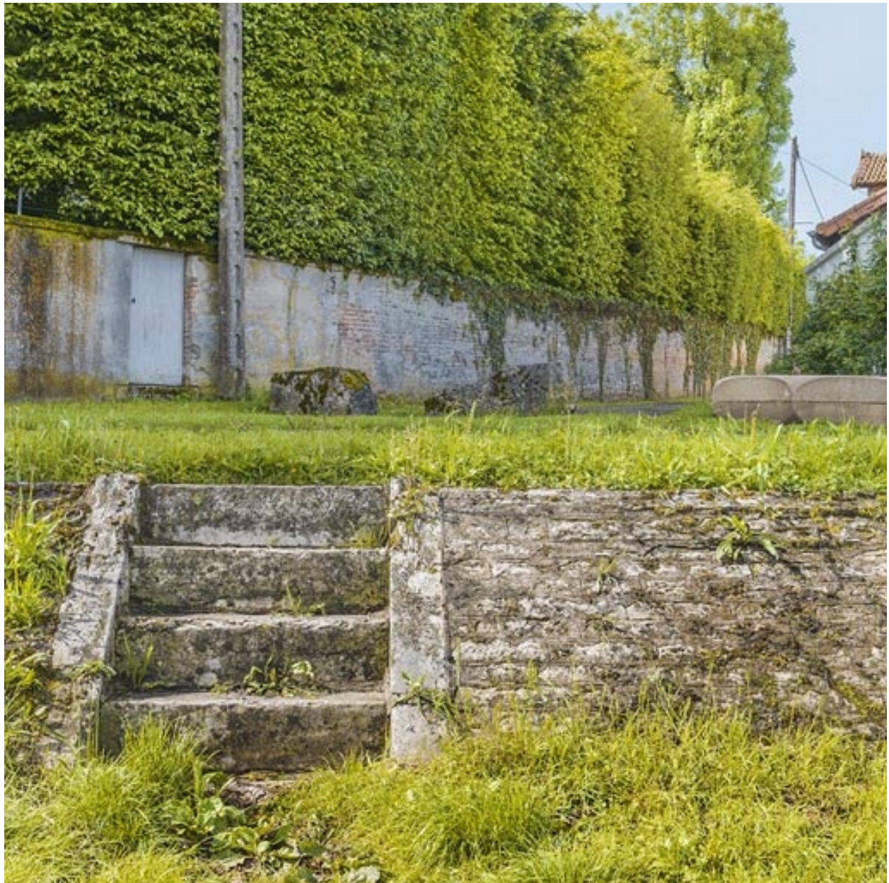
Deuxième escalier de la digue.
