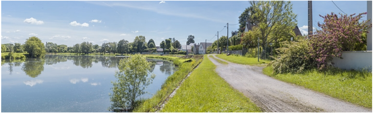
Vue d'ensemble de la digue, prise d'aval.
