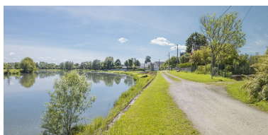
Vue d'ensemble de la digue, prise d'aval. Phot. Thierry Kuntz IVR26_20172100208NUC4A
