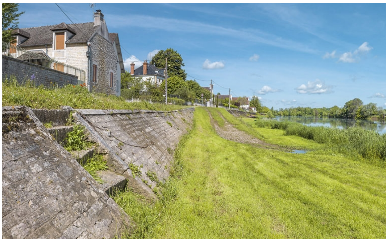
Escalier et rampe de la digue.
