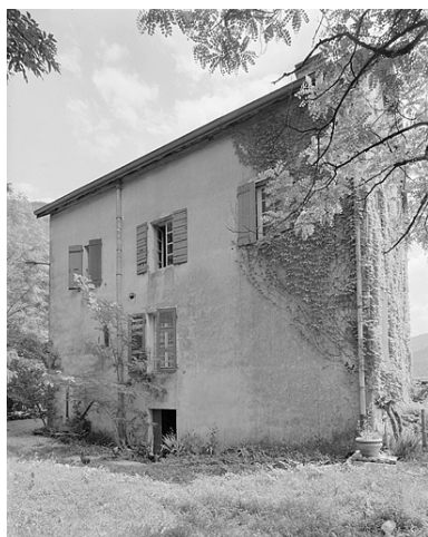
Façade droite avec accès au sous-sol. Phot. Jérôme Mongreville IVR43_19973900836V
