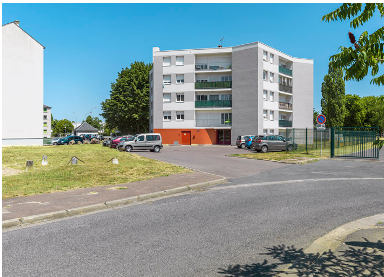
Bâtiment X, façades sud-ouest.
