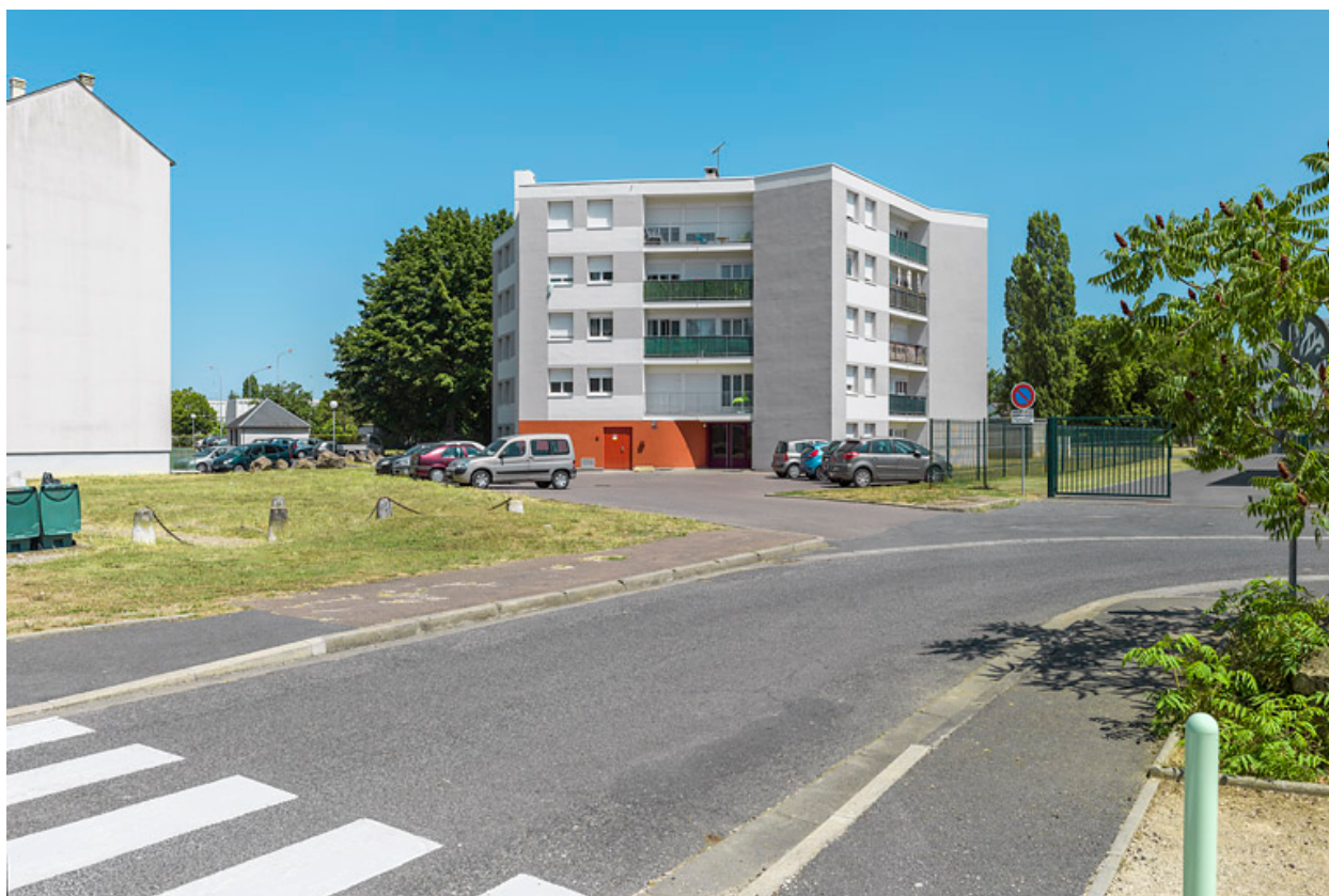
Bâtiment X, façades sud-ouest.
