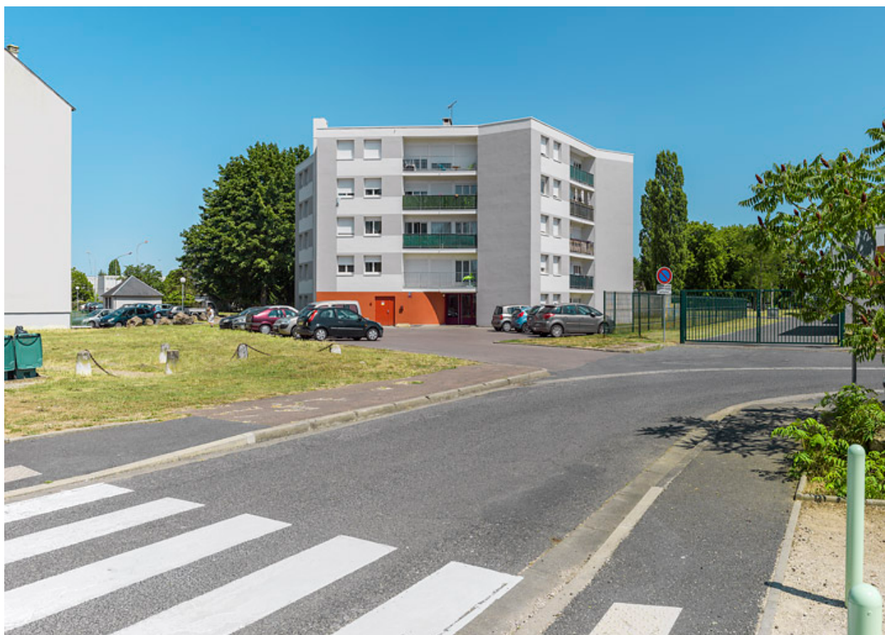
Bâtiment X, façades sud-ouest.
