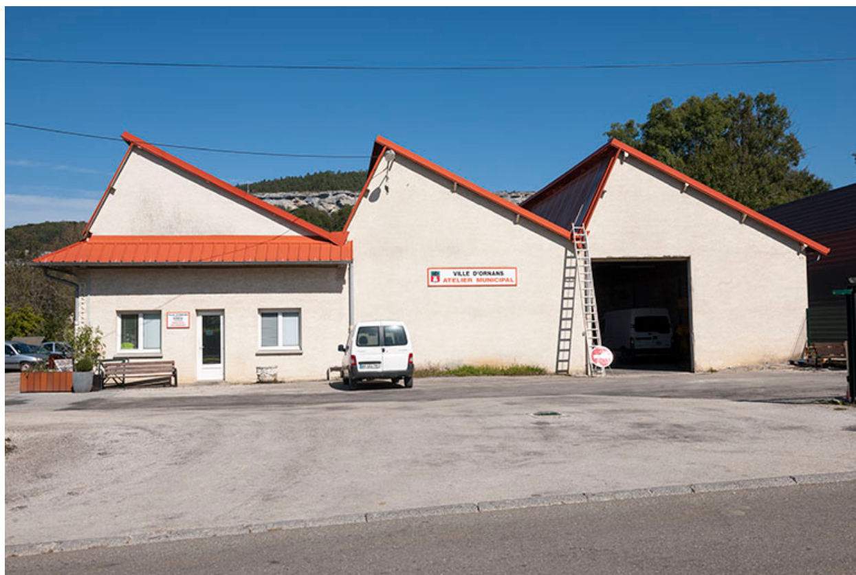
Pignons nords des sheds.
