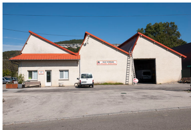
Pignons nords des sheds. Phot. Jérôme Mongreville IVR43_20152501742NUC4A
