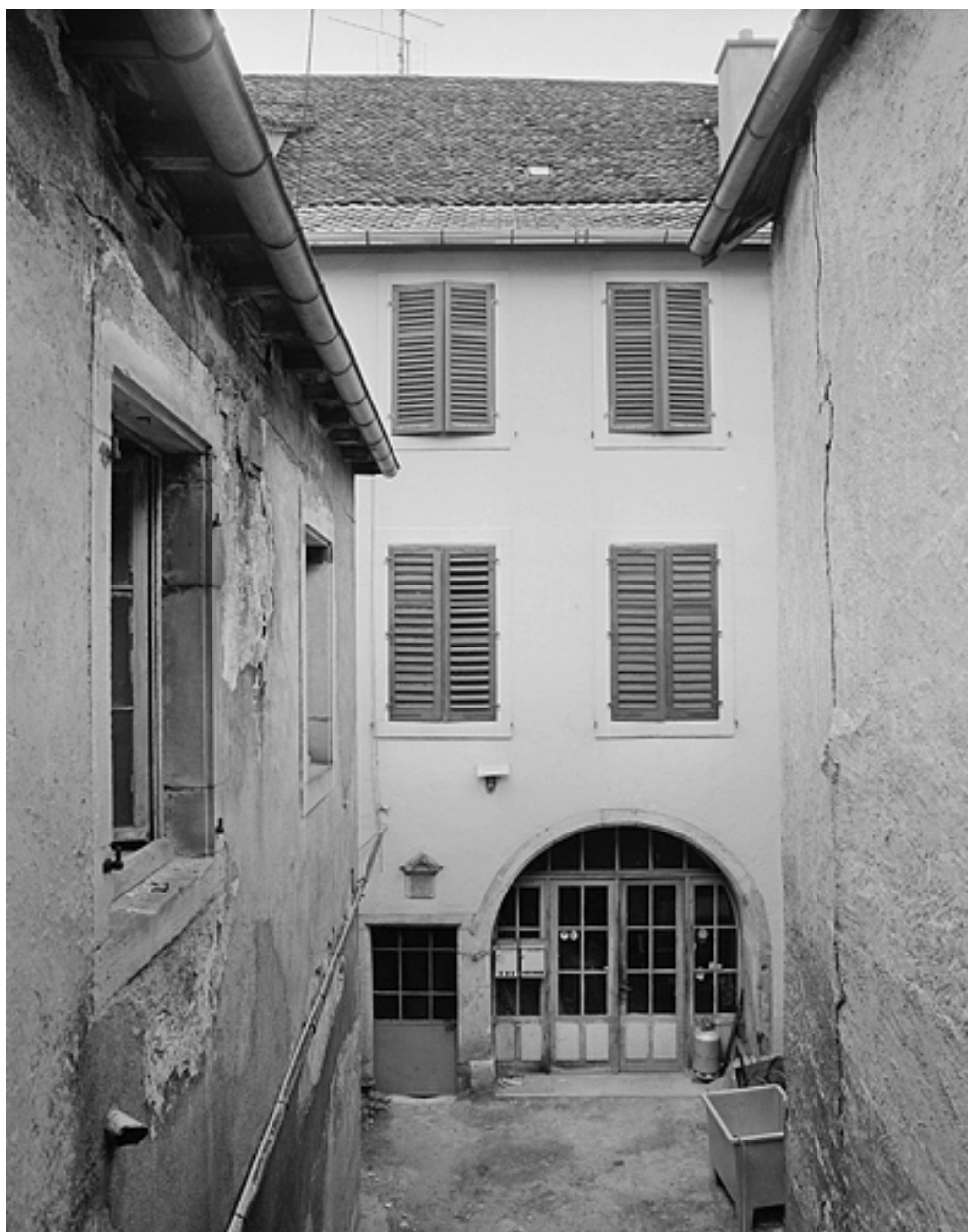
Cour et corps de bâtiment principal.
