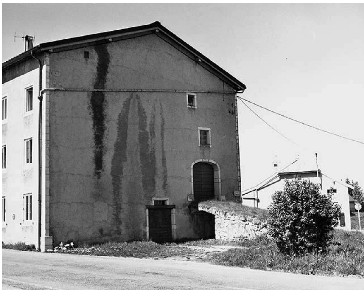
Façade postérieure et pont de grange.
