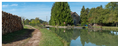
Vue d'ensemble prise d'amont. Phot. Pierre-Marie Barbe-Richaud IVR26_20128900598NUC4AQ
