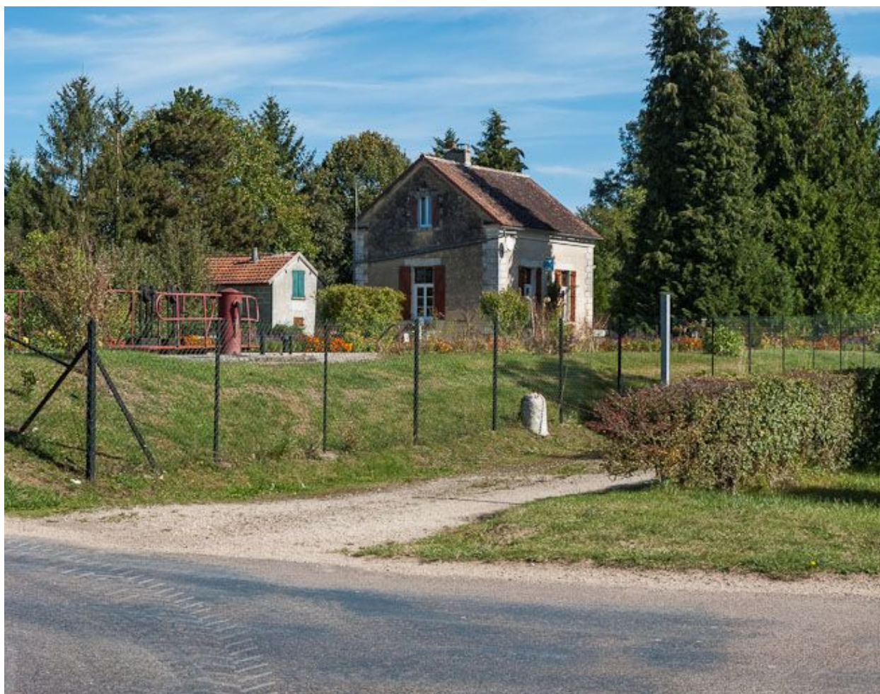
Maison éclusière. Borne au premier plan.
