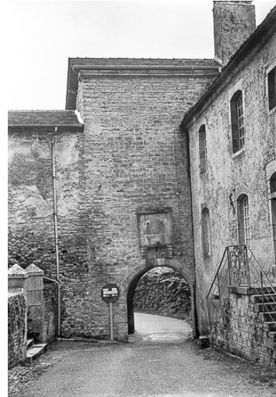
Porte de l'abbaye, face externe. Phot. Guy Forestier IVR43_19743900734Z
