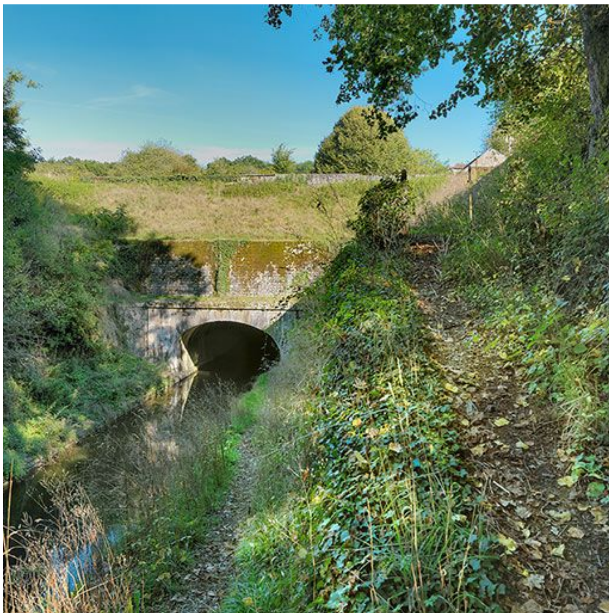
Entrée du tunnel de La Collancelle.
