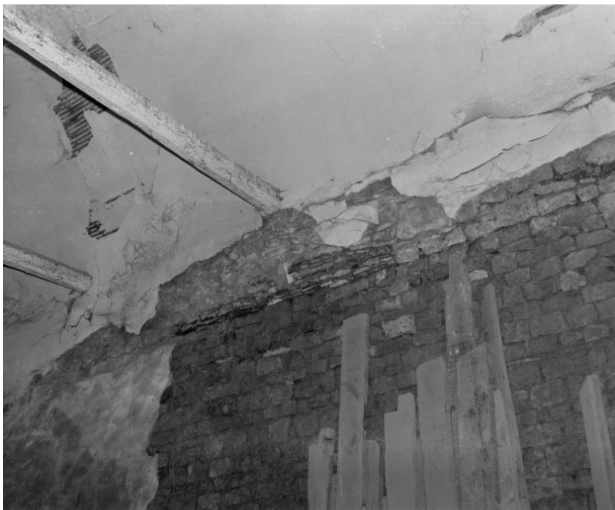
Mur gauche de la nef, détail.
