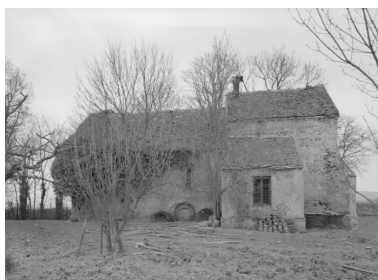
Elévation droite. Phot. Michel Thierry IVR26_19732100267V
