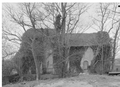
Elévation gauche. Phot. Michel Thierry IVR26_19732100264V
