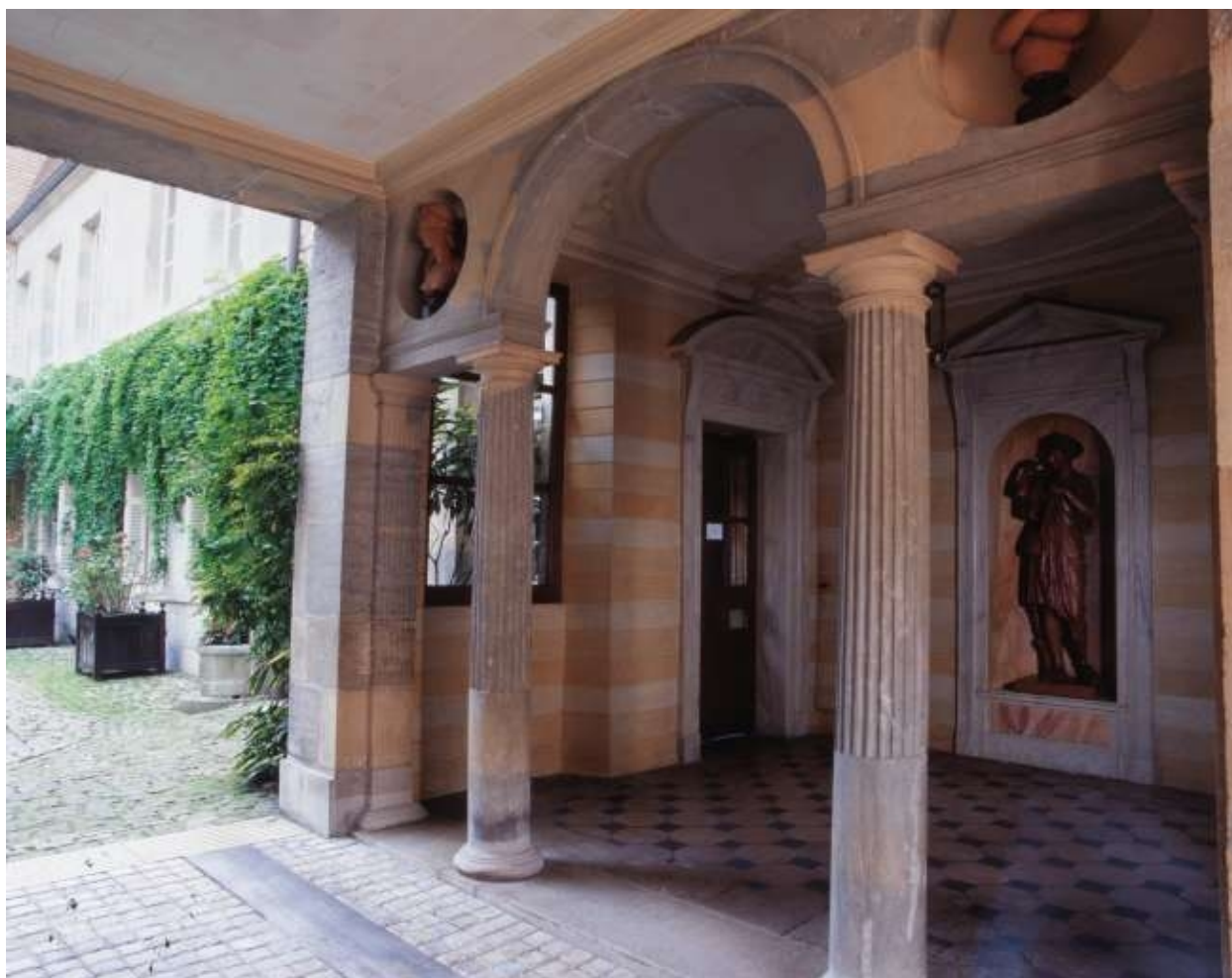
Passage d'entrée : détail de la partie droite.
