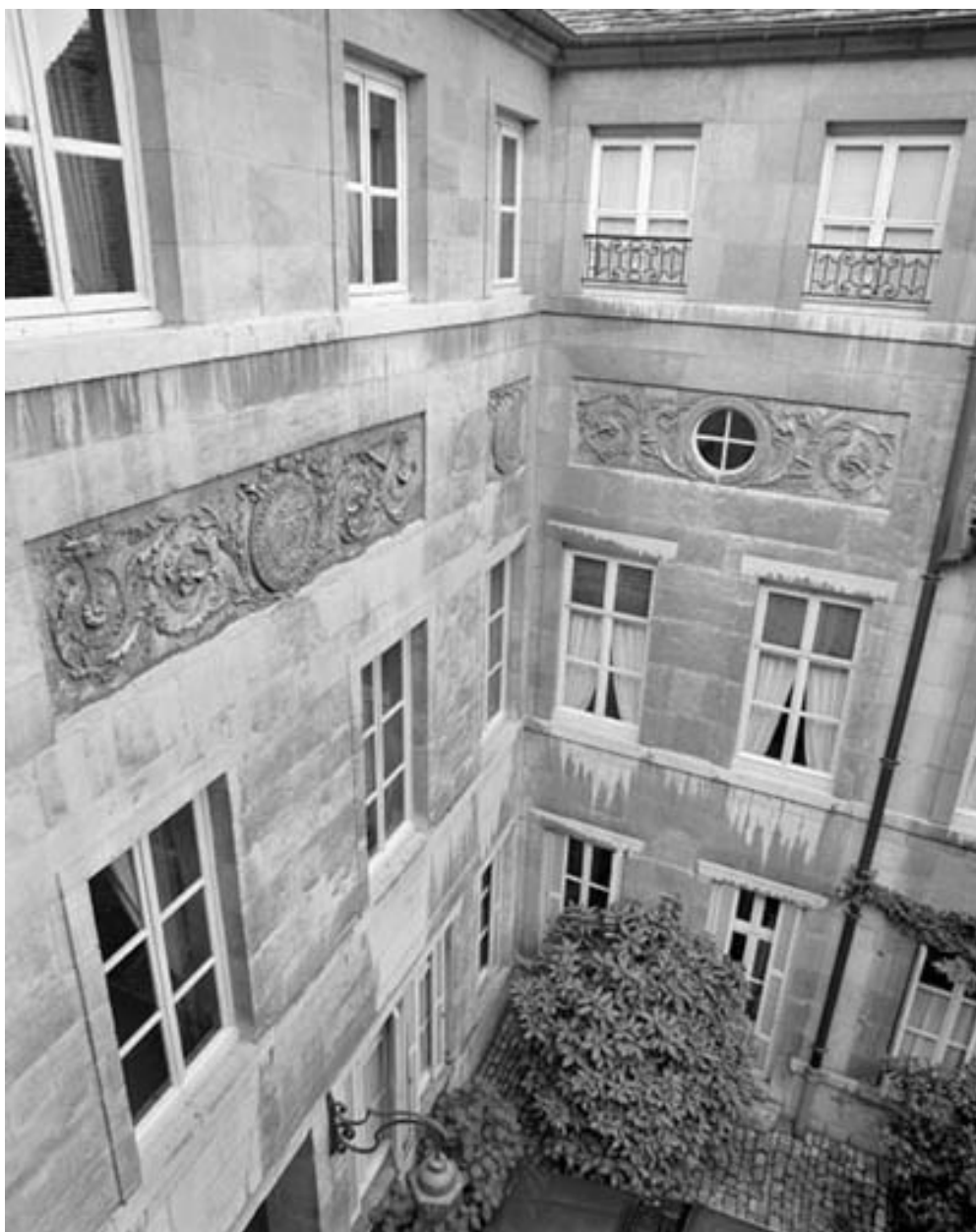
Façade sur cour depuis l'avant-corps gauche.
