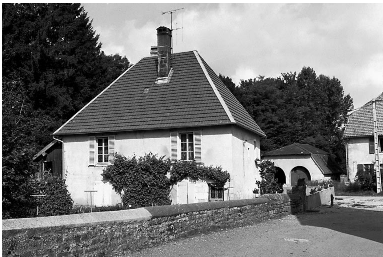
Maison située rue de l'Eglise.
