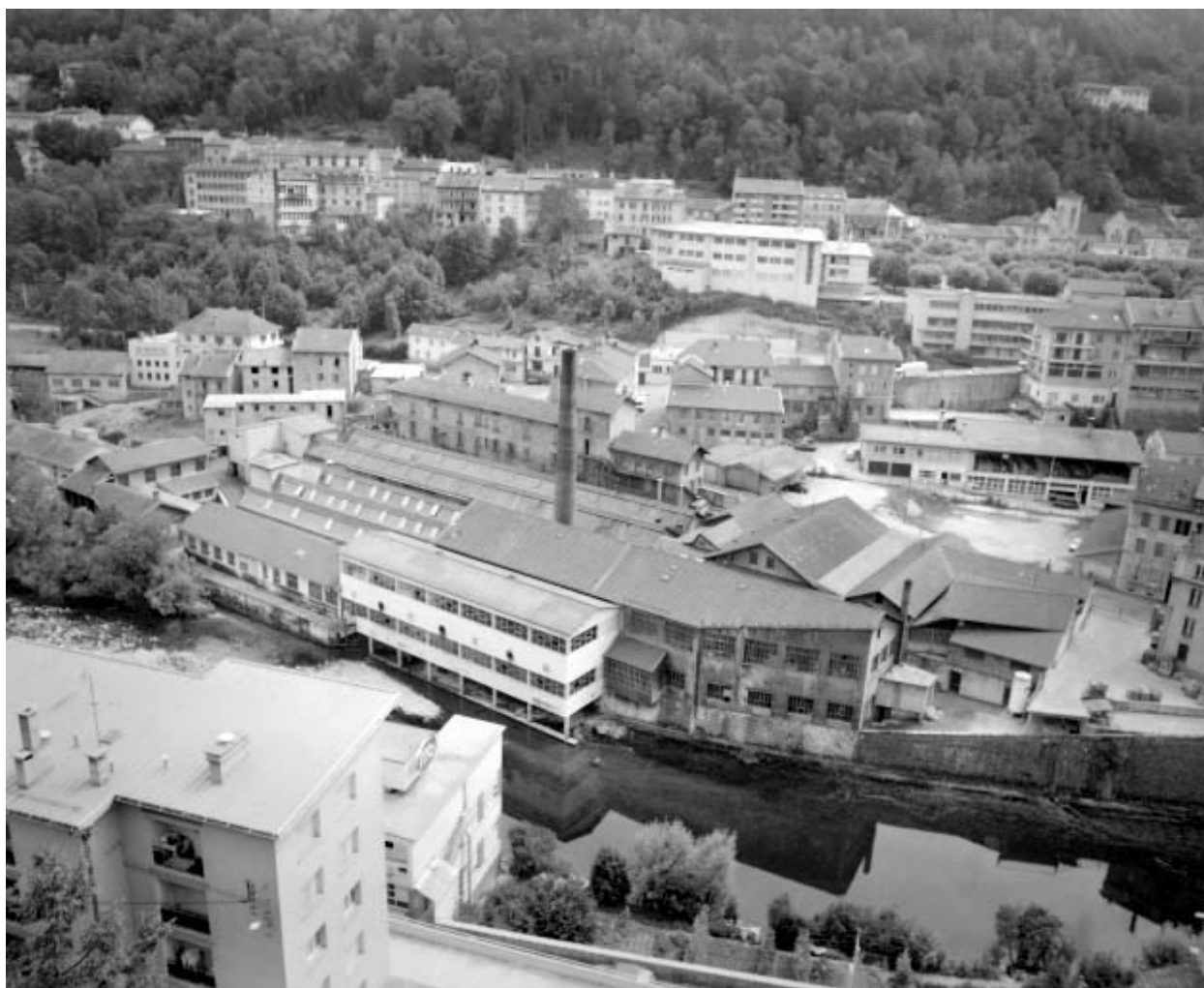
Vue d'ensemble plongeante depuis le nord-ouest.
