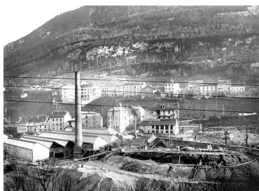
L'usine en cours d'agrandissement. Phot. Jérôme Mongreville IVR43_19923900007X
