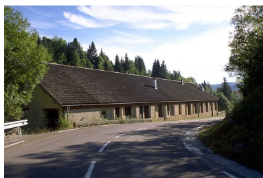
Façade ouest de l'atelier de fabrication.
