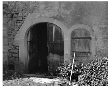
Détail : porte et fenêtre de l'étable. Phot. Bernard Lardière IVR43_19793900354X
