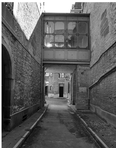
Passage cocher depuis la rue. Phot. Jérôme Mongreville IVR43_19992500144X
