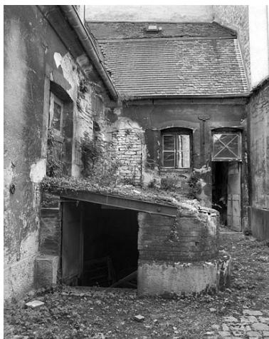
Vue de l'étable, de face. Phot. Jérôme Mongreville IVR43_19992500143X
