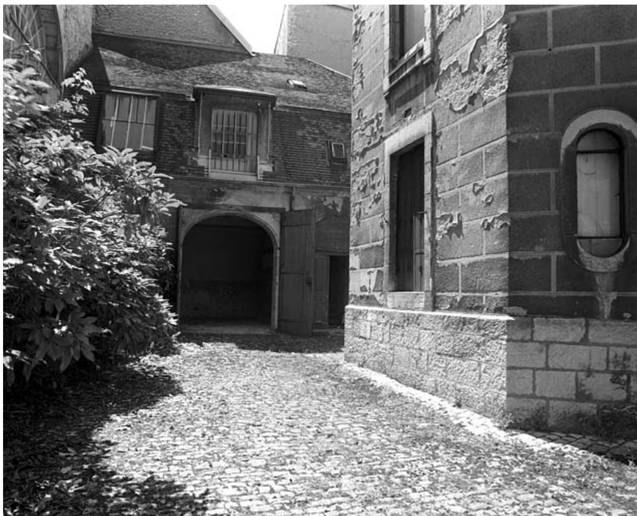
Vue du bâtiment des remises, de face.
