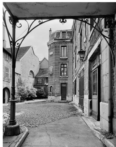
Vue de la cour. Phot. Jérôme Mongreville IVR43_19992500113V
