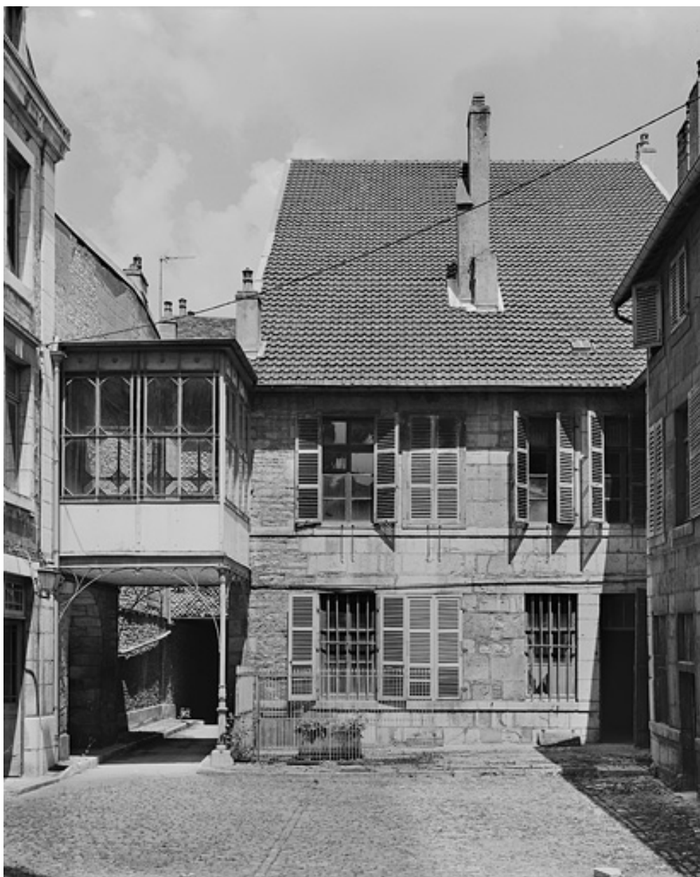
Logis sur rue : façade postérieure.
