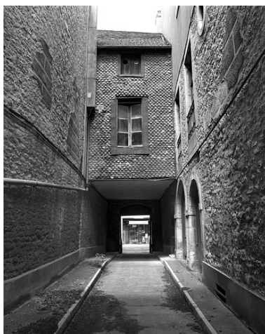
Passage cocher depuis la cour. Phot. Jérôme Mongreville IVR43_19992500139X
