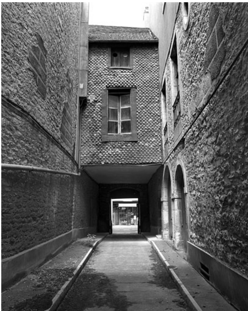
Passage cocher depuis la cour.
