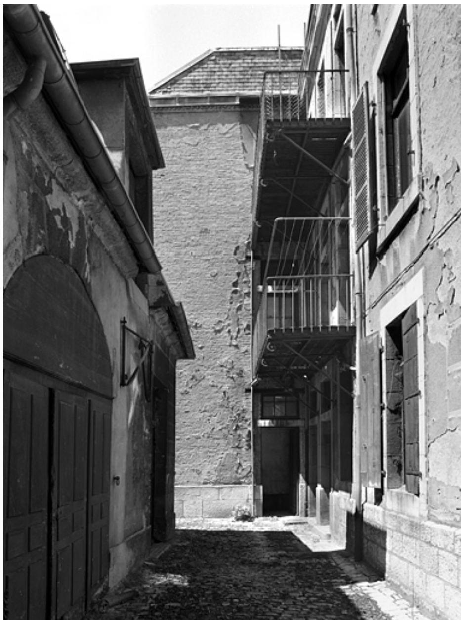
Logis secondaire droit : façade latérale gauche.
