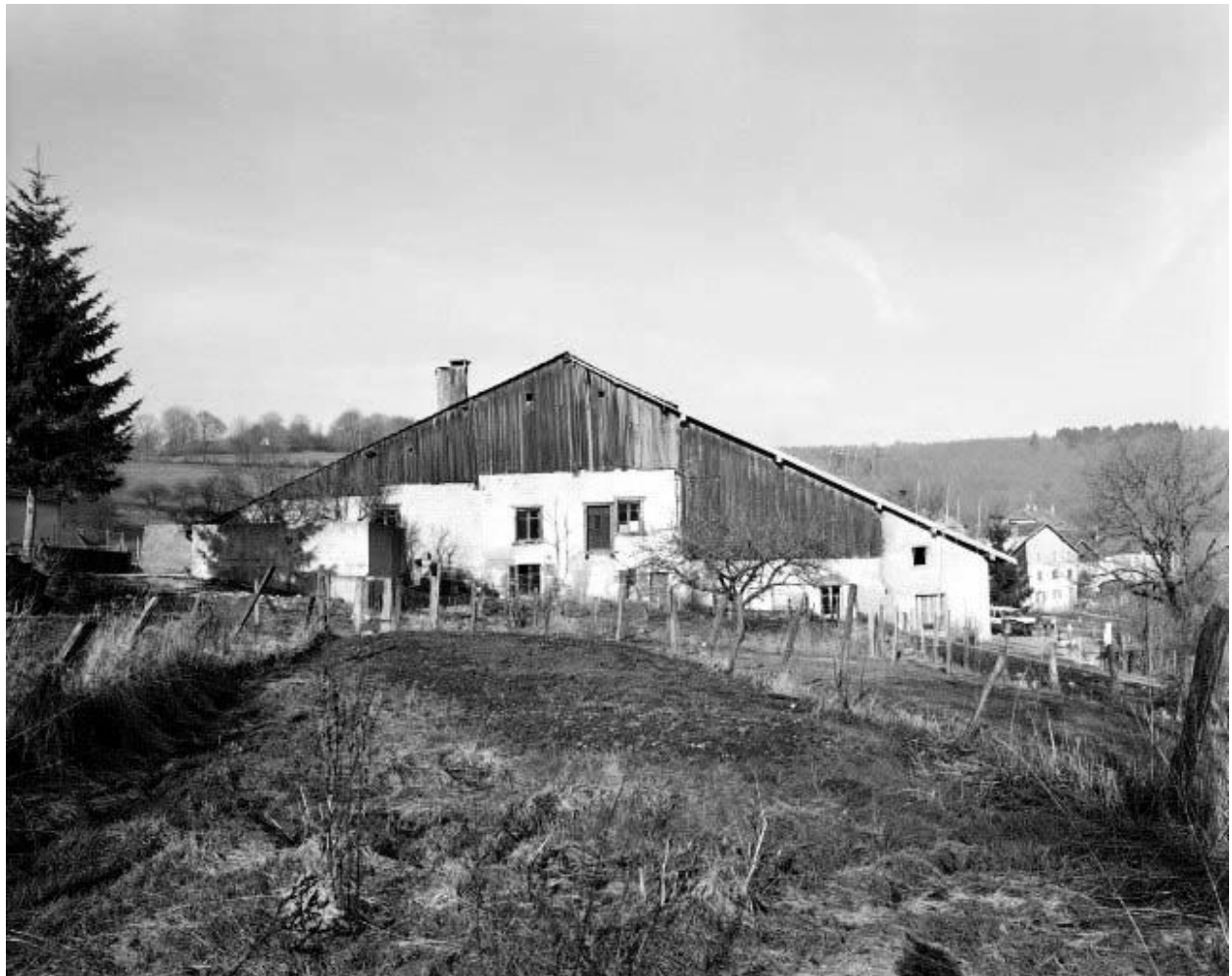
Ferme située rue de la Poste.
