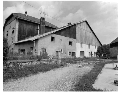
Ferme située rue du Moulin Phot. Bernard Lardière IVR43_19782500243X
