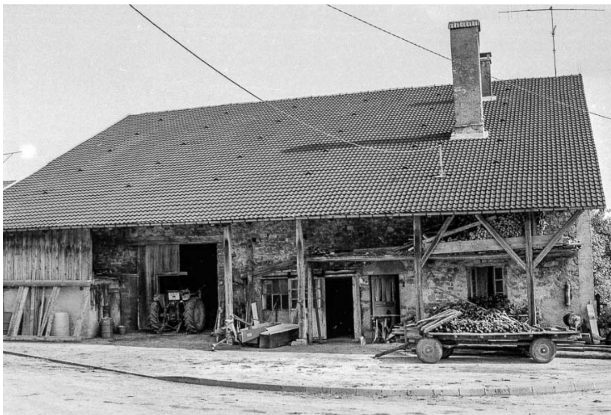
Gouttereau sur rue.
