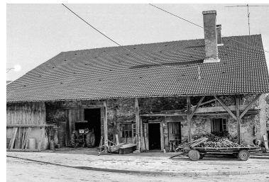
Gouttereau sur rue. Phot. Gilbert Poinot IVR43_19752501265Z
