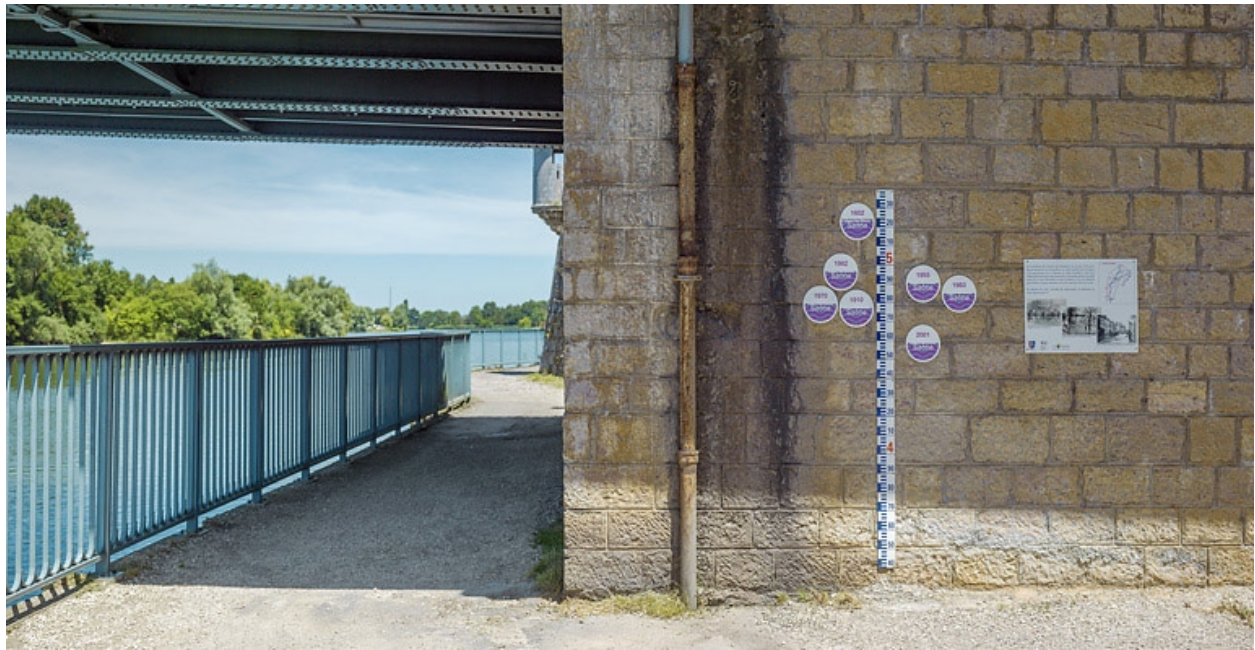
Détail des repères de crues.
