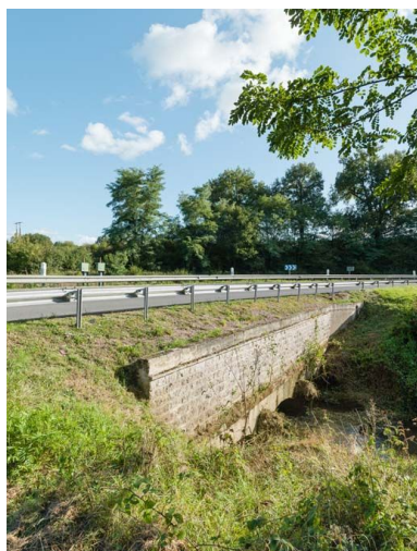
Vue de l'aqueduc. Phot. Pierre-Marie Barbe-Richaud IVR26_20177100302NUC2A
