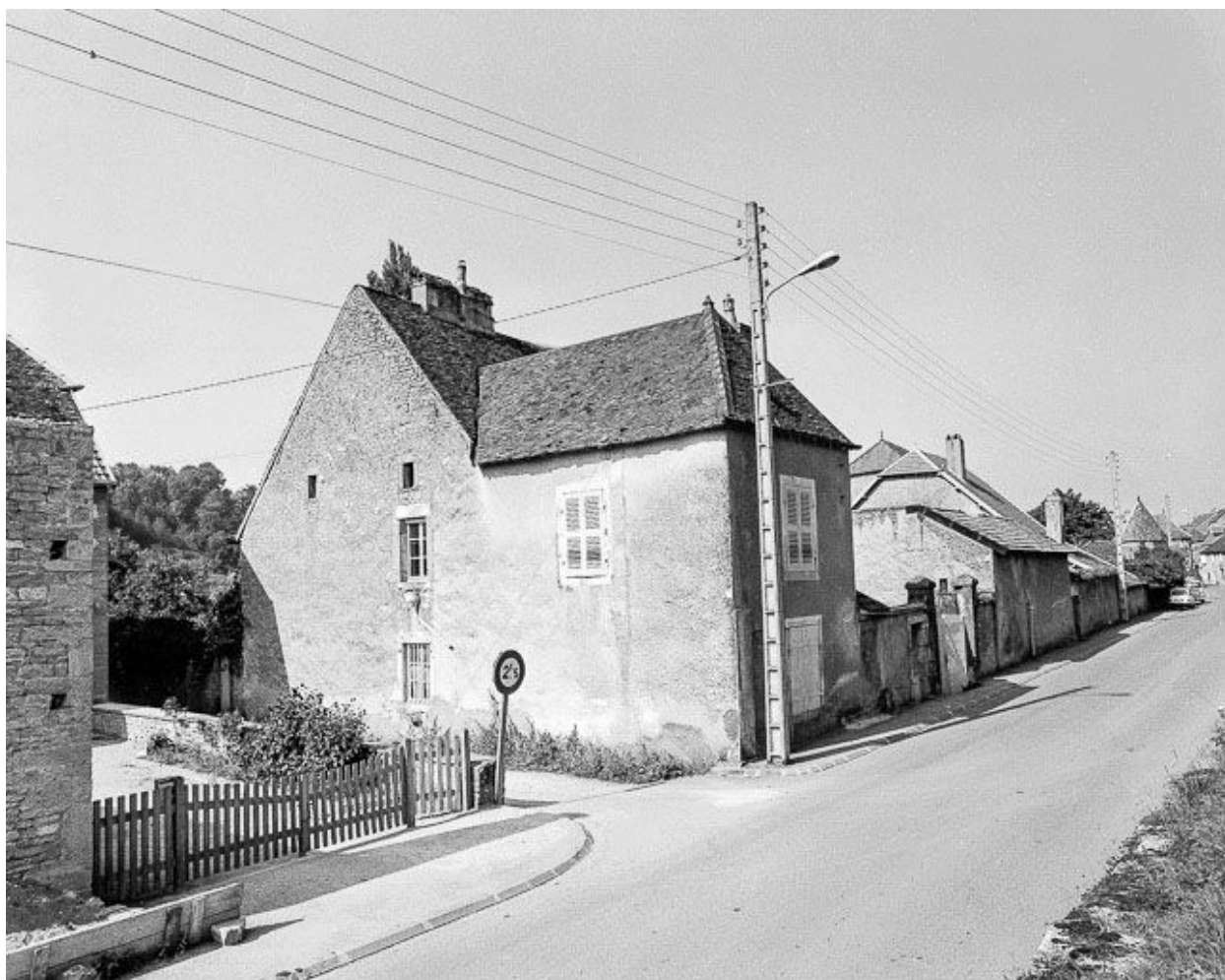
Façade latérale gauche.
