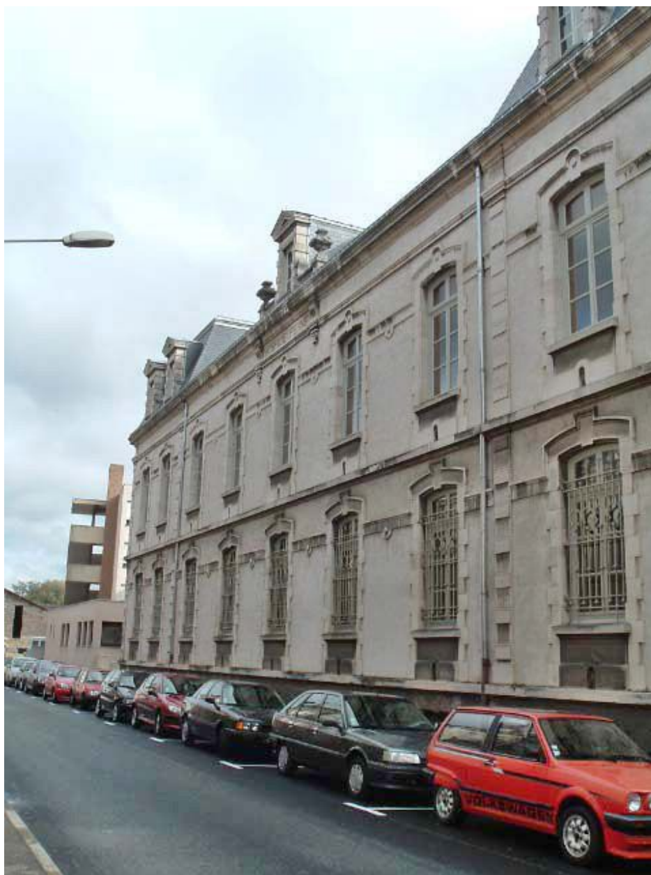
Vue générale latérale de la façade postérieure.
