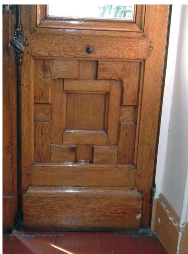
Vue de détail d'un panneau bois d'une porte d'entrée, assemblage vu de l'intérieur du bâtiment. Phot. Sylvie Le Clech-Charton IVR26_20057102347NUC1A
