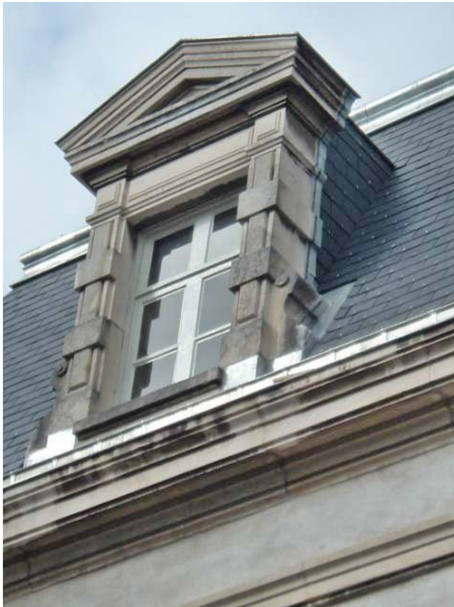
Vue de détail d'une lucarne.
