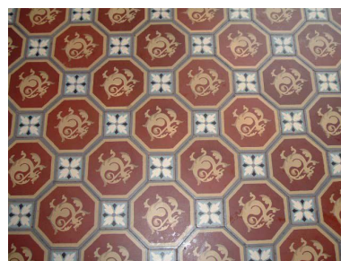
Vue de détail d'un ensemble de carreaux de ciment du rez-de-chaussée. Phot. Sylvie Le Clech-Charton IVR26_20057102356NUC1A
