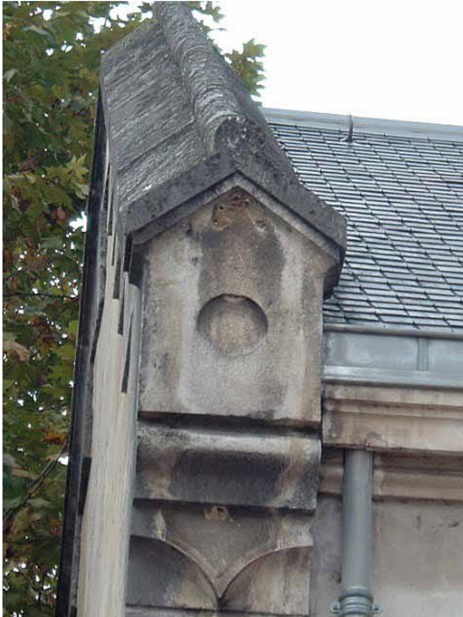
Vue de détail : rampant du pignon découvert.
