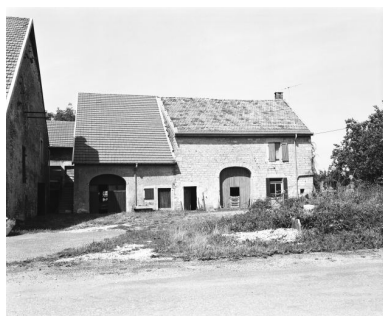
Façade antérieure. Phot. Yves Sancey
