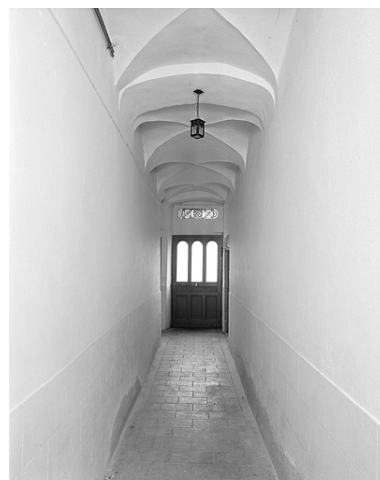
Couloir du rez-de-chaussée. Phot. Jérôme Mongreville IVR43_19963901161X
