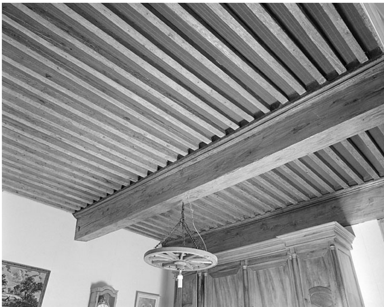
Plafond d'une pièce de l'étage.
