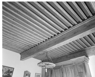
Plafond d'une pièce de l'étage. Phot. Jérôme Mongreville IVR43_19963901158X
