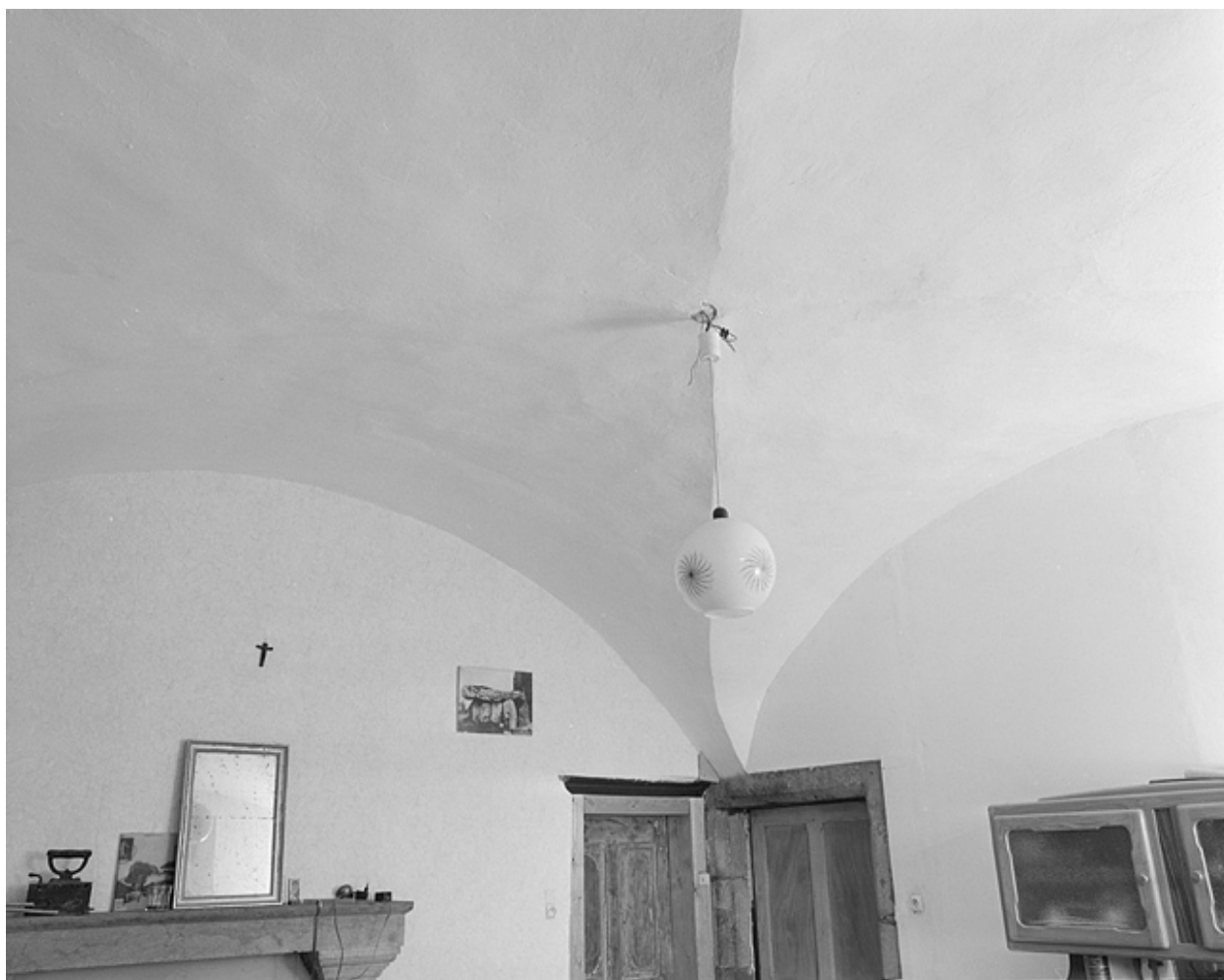
Pièce du rez-de-chaussée, voûte d'arêtes.
