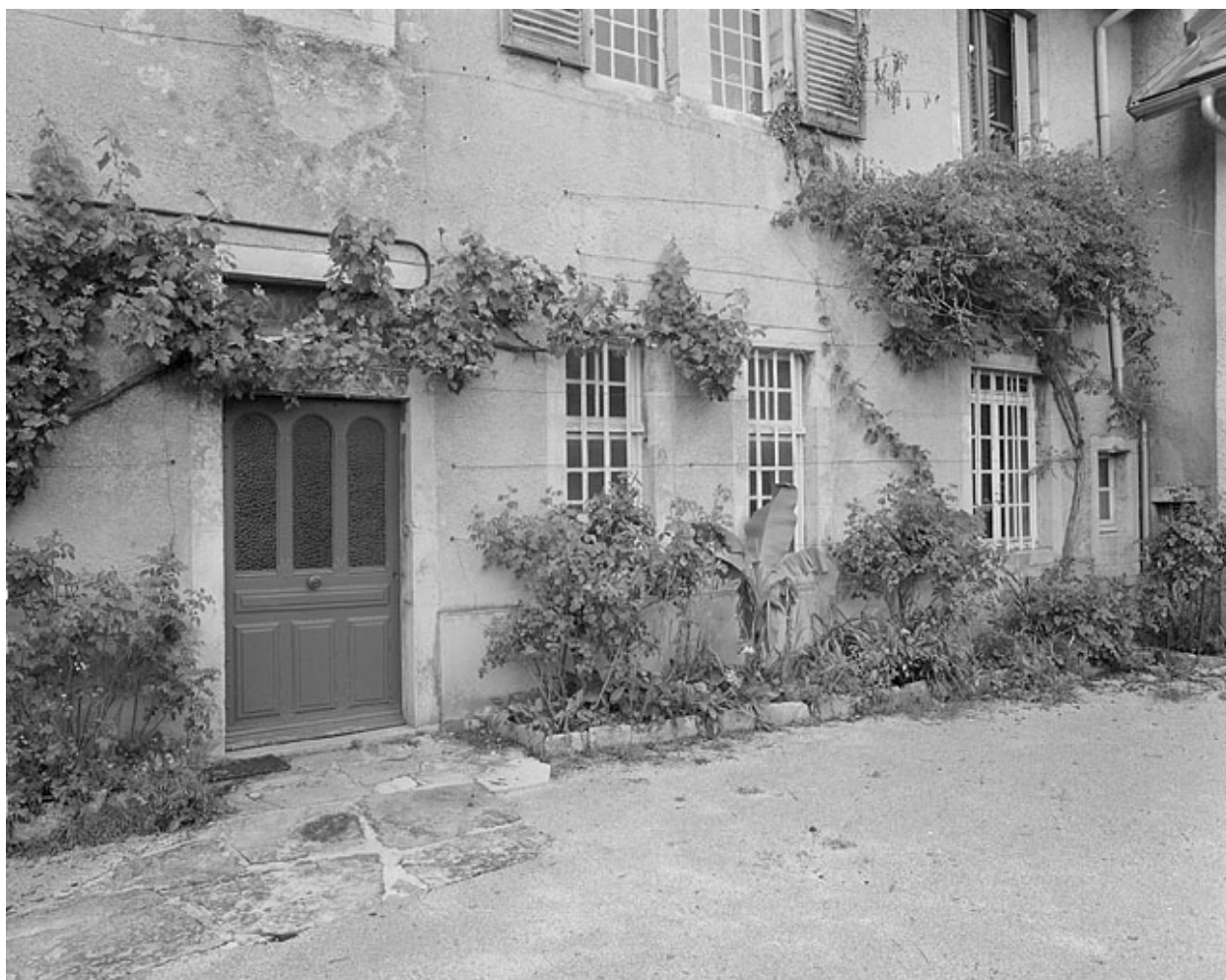
Façade antérieure, partie droite.
