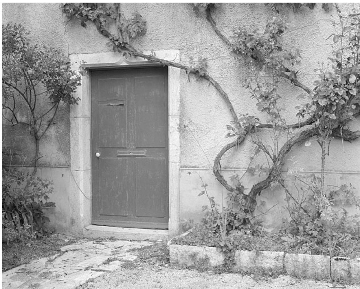
Façade antérieure, détail d'une porte.
